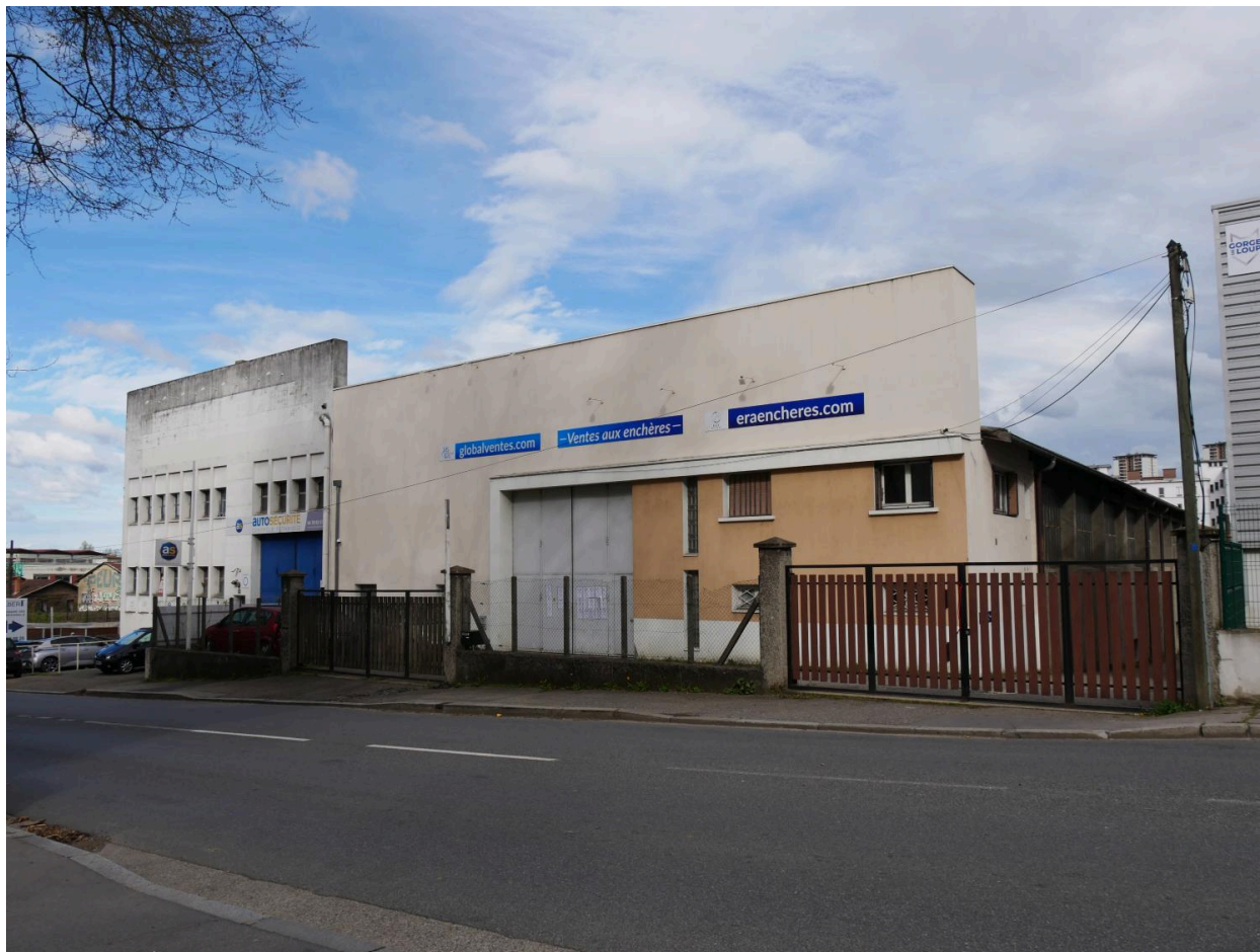
Vue d'ensemble du centre de contrôle à Vaise
