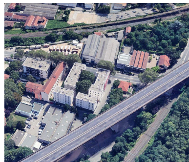
Vue d'ensemble rue Sidoine Apollinaire (vue Google) Phot. Nadine Halitim-Dubois IVR84_20246900663NUCA
