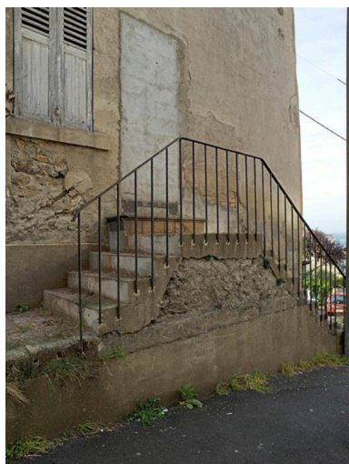
Escalier extérieur privé, au bas de la rue. Phot. Jean-Michel Périn IVR83_20116301087NUC4A
