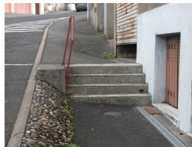
Emmarchements d'un trottoir de la rue, aménagé pour la pente (photographie chercheur). Phot. Brigitte Ceroni IVR83_20096300562NUCA
