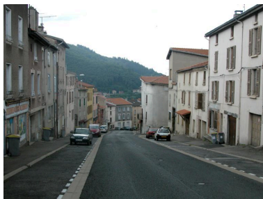
Partie supérieure de la rue en direction du bas. En perspective, les versants de la rive gauche de la Durolle (photographie chercheur). Phot. Brigitte Ceroni IVR83_20096300561NUCA
