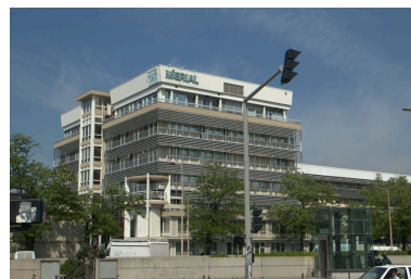
Vue sud-ouest du bâtiment principal Phot. Nadine Halitim-Dubois IVR82_20086900452NUCA
