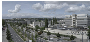
Vue d'ensemble sud-est Phot. Eric Dessert IVR82_20086902476NUCA
