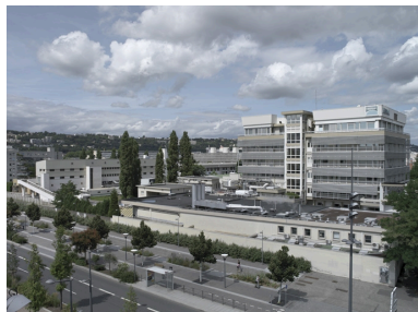
Vue d'ensemble sud Phot. Eric Dessert IVR82_20086902398NUCA
