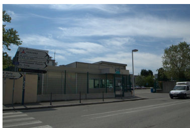
Vue est, rue du Vercors Phot. Nadine Halitim-Dubois IVR82_20086900457NUCA
