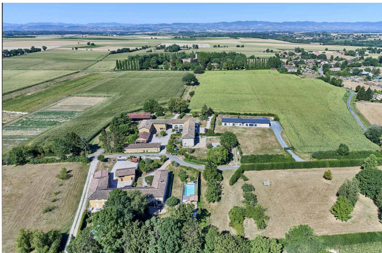
Vue aérienne de l'écart des Granges Gourroux, depuis l'est
