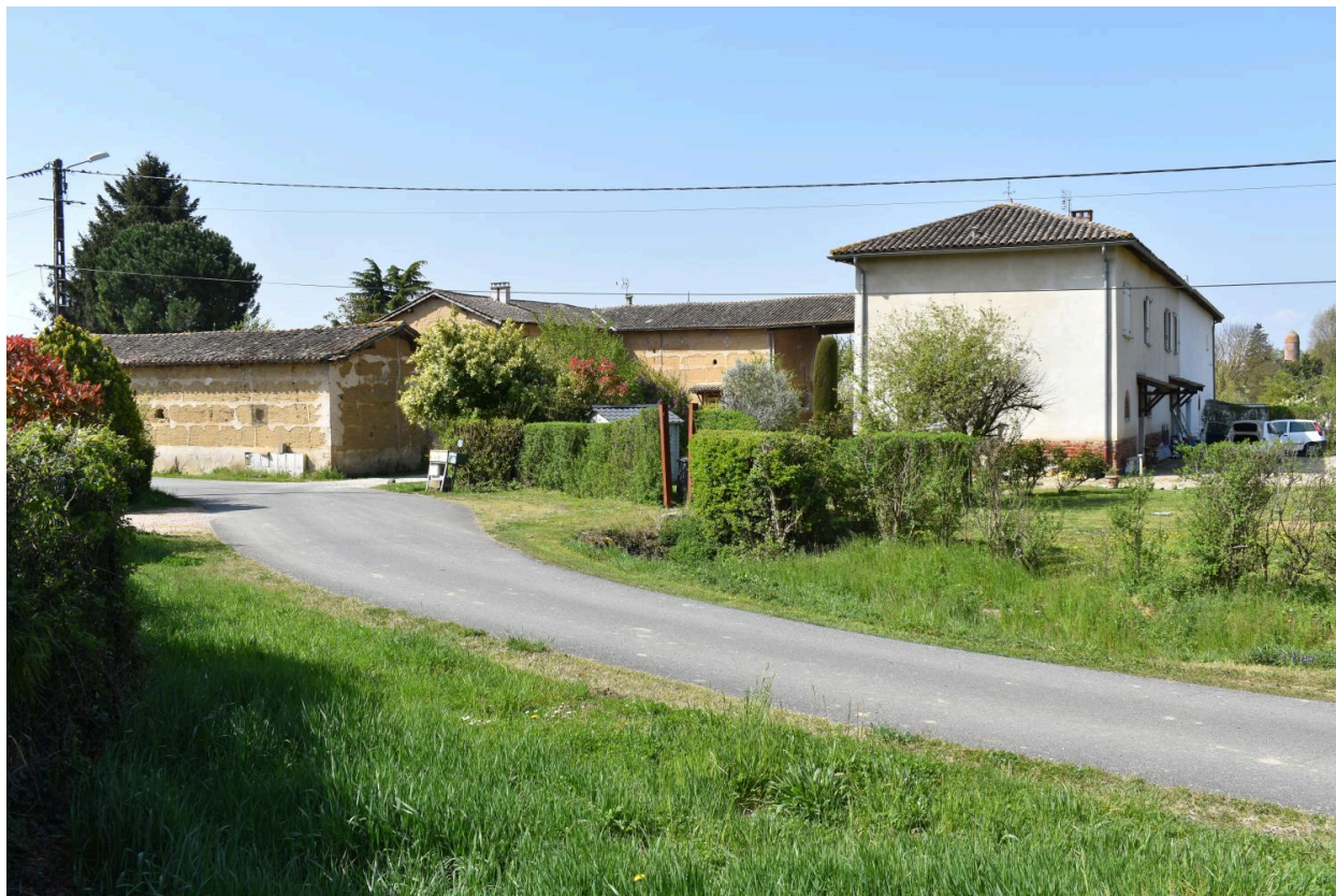
Vue générale de l'ensemble à l'ouest
