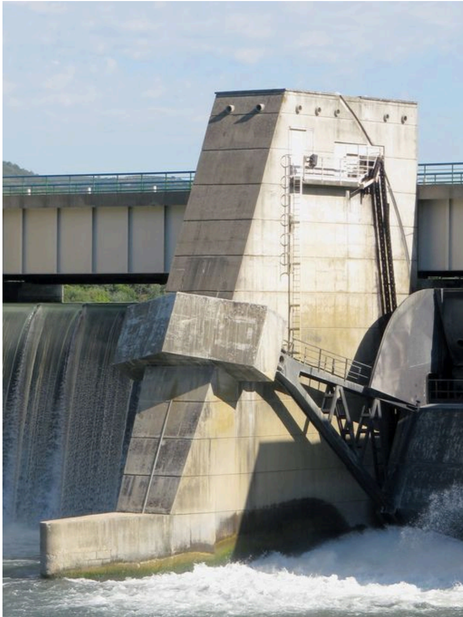
Pile, vue partielle face aval (depuis la rive gauche)
