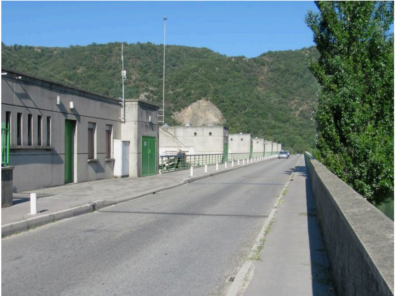
Chaussée du pont routier (depuis la rive gauche)
