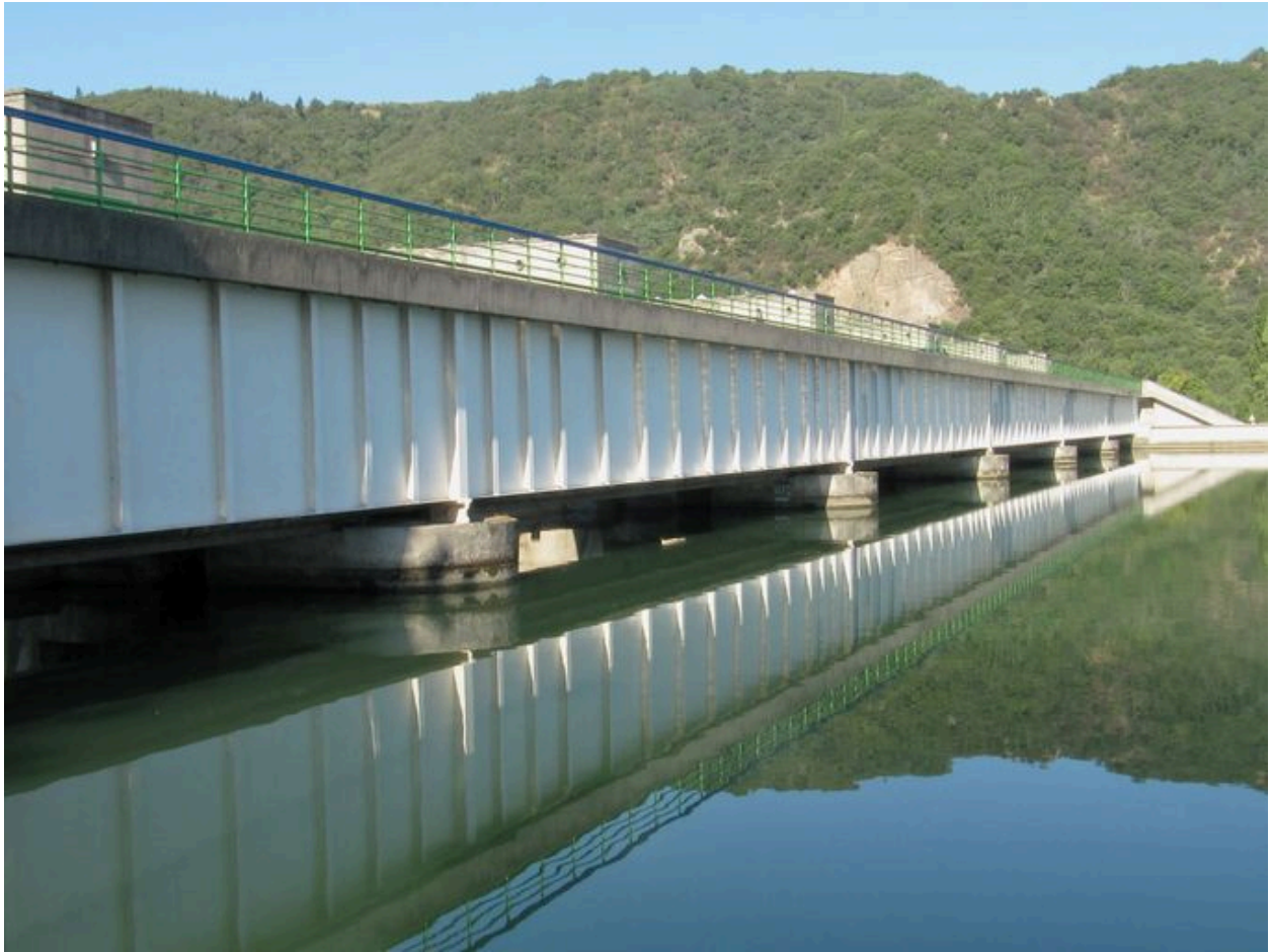
Poutre du pont, vue partielle face amont (depuis la rive gauche)
