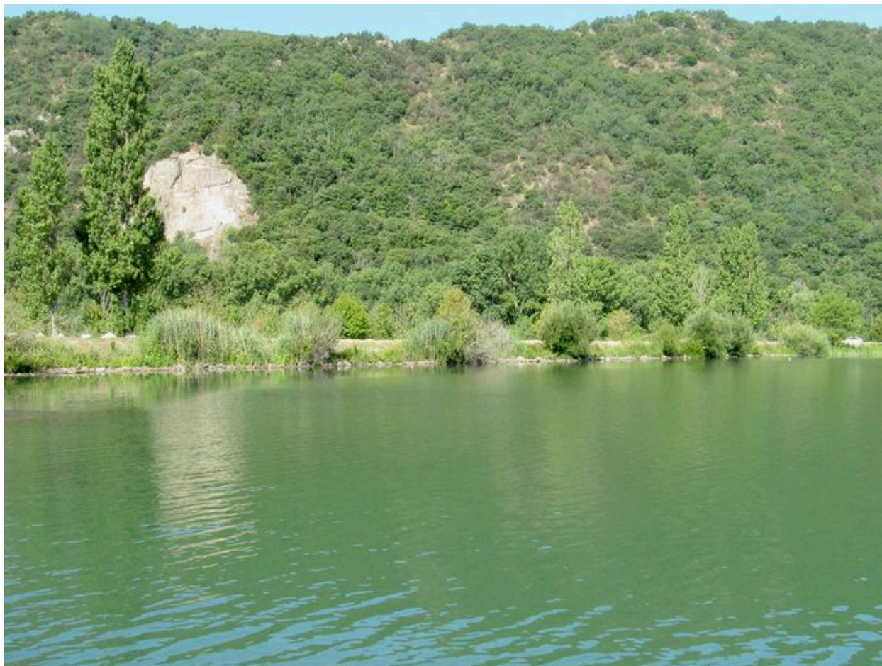
Pont-digue de la rive droite, vue générale
