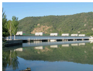
Vue générale, face amont (depuis la rive gauche) Phot. I. Havard IVR82_20102600068NUCA
