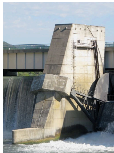
Pile, vue partielle face aval (depuis la rive gauche) Phot. I. Havard IVR82_20102600071NUCA
