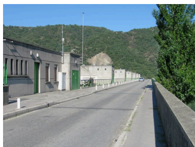
Chaussée du pont routier (depuis la rive gauche) Phot. I. Havard IVR82_20102600072NUCA
