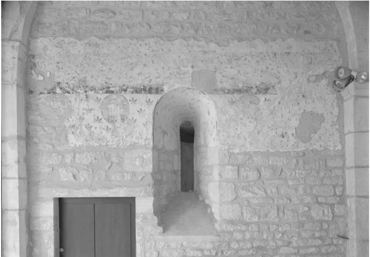
Vue d'ensemble des vestiges.
