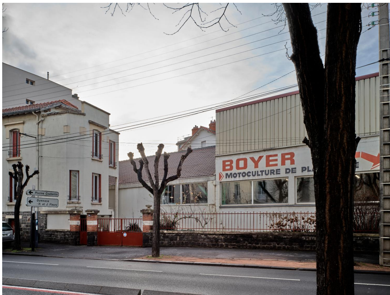
Elévation de l'immeuble et du commerce de motoculture sur la cour, le long du boulevard Jean-Jaurès.
