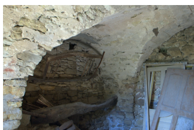
Vue partielle de l'écurie voûtée d'arêtes
