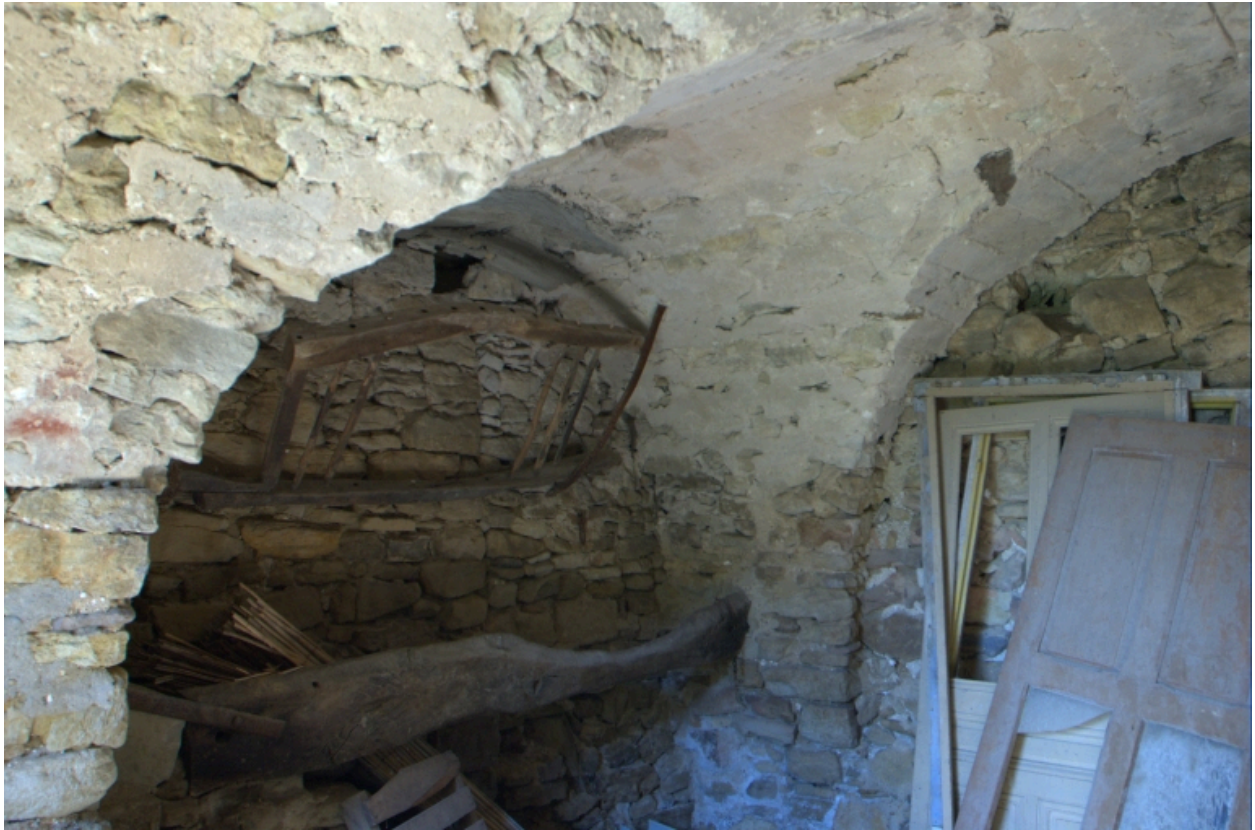
Vue partielle de l'écurie voûtée d'arêtes
