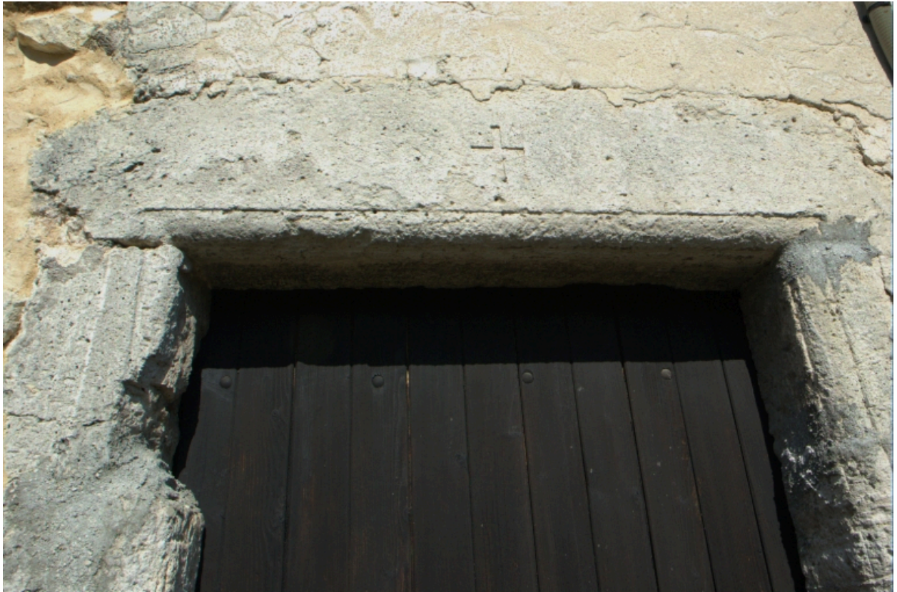
Détail de la porte d'entrée dans l'élévation latérale gauche : linteau gravé d'une croix.
