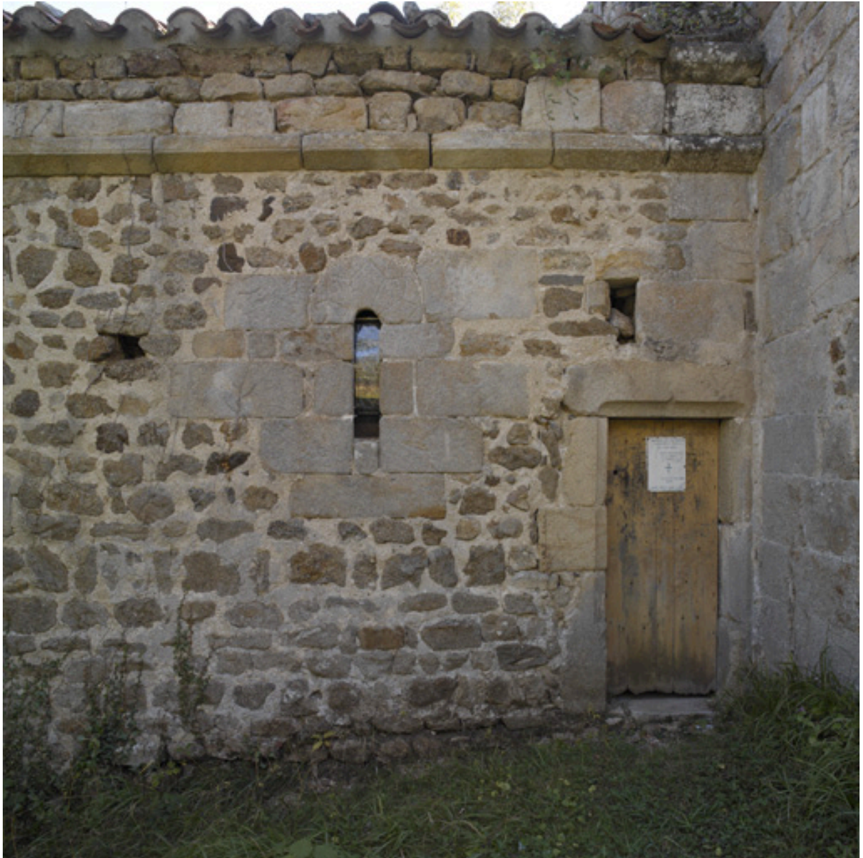
Vue du mur nord du choeur.
