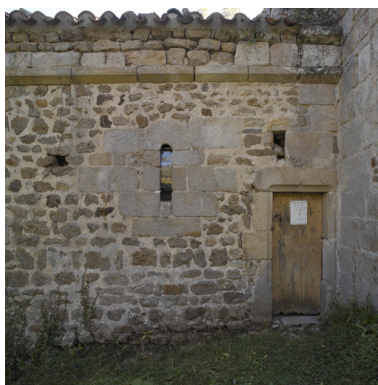
Vue du mur nord du chœur. Phot. Eric Dessert IVR82_20124200402NUCA
