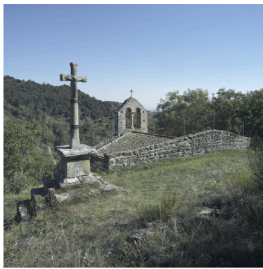
Vue générale depuis l'ouest, avec la croix. Phot. Eric Dessert IVR82_20124200398NUCA
