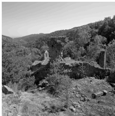
Vue générale depuis le nord-ouest. Au premier plan, ruines du château. Phot. Eric Dessert IVR82_20124200400NUC
