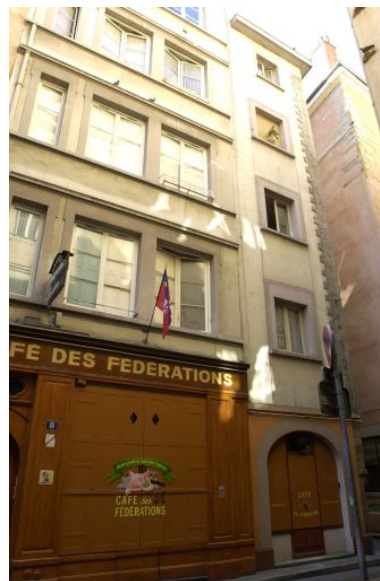
Façade sur la rue Major-Martin Phot. Maryannick Chalabi IVR82_20036901057NUCA
