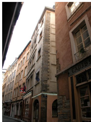
Angle des deux façades, niveaux 2 à 5 Phot. Bernard Ducouret IVR82_20036901065NUCA
