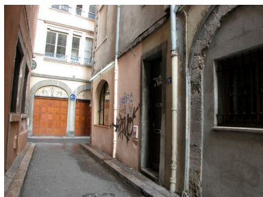
Façade sur la rue Valfenière, rez-de-chaussée Phot. Bernard Ducouret IVR82_20046900299NUCA
