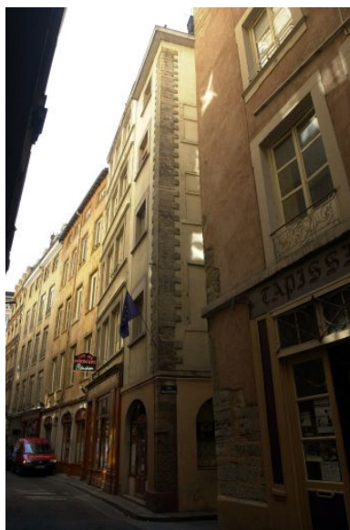
Angle des deux façades Phot. Bernard Ducouret IVR82_20036901254NUCA
