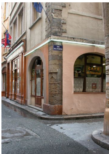
Angle des deux façades, premier niveau Phot. Bernard Ducouret IVR82_20036901064NUCA
