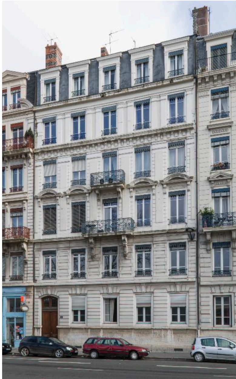
Vue générale de l'élévation sur quai
