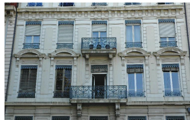
Vue rapprochée des deuxièmes et troisièmes étages carrés Phot. Magali Delavenne IVR82_20146902802NUCA
