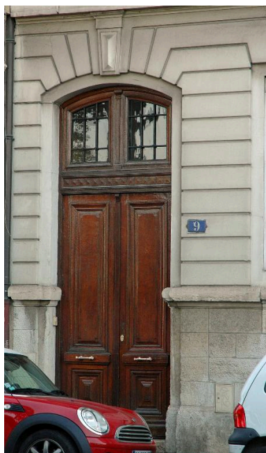
Vue rapprochée de la porte d'entrée Phot. Magali Delavenne IVR82_20146902803NUCA
