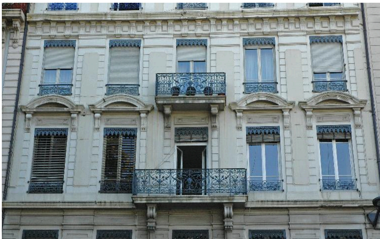
Vue rapprochée des deuxièmes et troisièmes étages carrés
