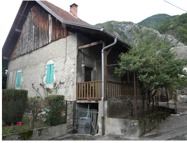
Vue de trois quarts depuis le sud Phot. Jérôme Daviet IVR82_20127403159NUCA
