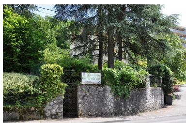
Mur de soutènement et portail d'entrée donnant sur le boulevard Phot. Denys Harreau IVR82_20137300431NUCA
