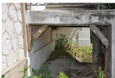
Aisseliers en rocaille supportant l'escalier extérieur Phot. Denys Harreau IVR82_20137300423NUCA
