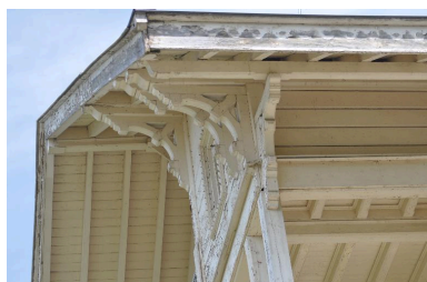
Aisseliers en bois sous l'avant-toit Phot. Denys Harreau IVR82_20137300426NUCA
