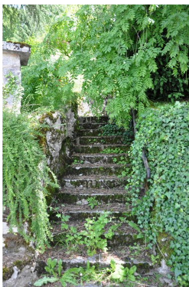
Escalier parcourant le jardin Phot. Denys Harreau IVR82_20137300422NUCA
