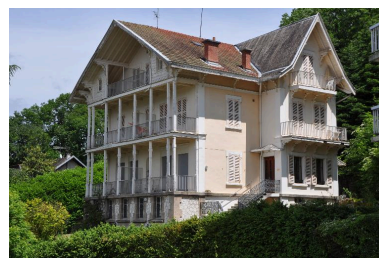
Vue de trois-quart droit Phot. Denys Harreau IVR82_20137300419NUCA
