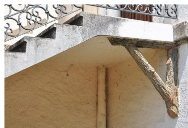
Aisselier en rocaille supportant l'escalier extérieur Phot. Denys Harreau IVR82_20137300424NUCA
