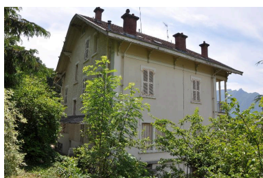
Elévations postérieure et latérale gauche (façade est et nord) Phot. Denys Harreau IVR82_20137300428NUCA
