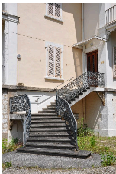
Escalier et porte d'entrée Phot. Denys Harreau IVR82_20137300427NUCA
