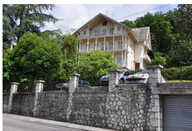
Vue d'ensemble depuis le boulevard de la Roche-du-Roi Phot. Denys Harreau IVR82_20137300430NUCA
