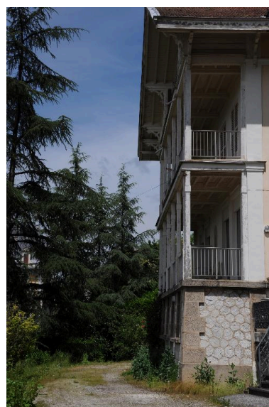
Détail de l'étage de soubassement et des balcons-loggias sur la façade principale Phot. Denys Harreau IVR82_20137300421NUCA
