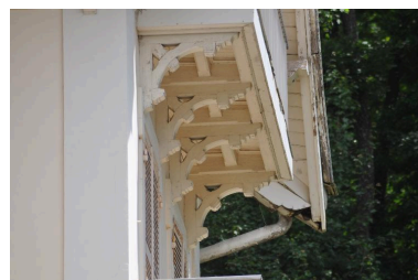
Aisseliers en bois supportant un balcon Phot. Denys Harreau IVR82_20137300420NUCA
