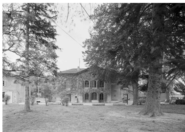
Façade sur jardin. Phot. Eric Dessert IVR82_19910100564P
