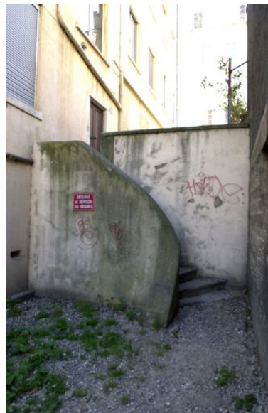
L'escalier donnant accès à la rue Casimir-Perier Phot. Maryannick Chalabi IVR82_20036900371NUCA
