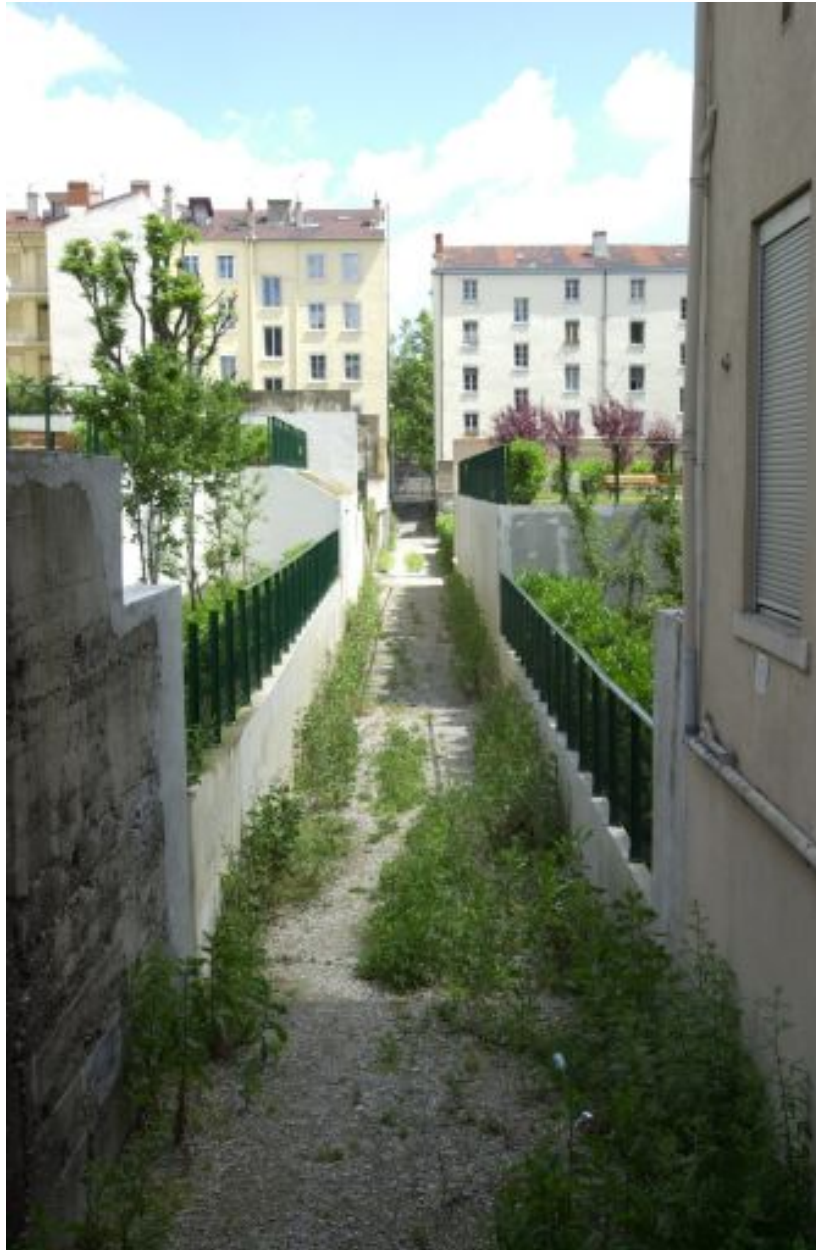
Vue générale depuis la rue Casimir-Perier
