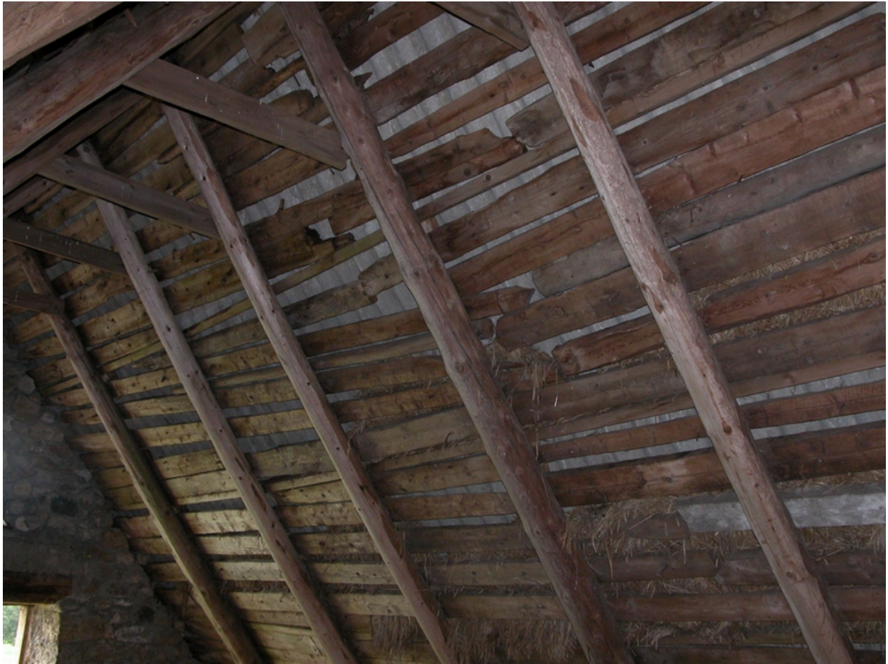
Vue intérieure de la charpente.
