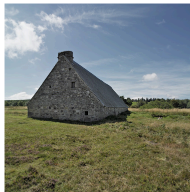
Vue du pignon nord. Phot. Eric Dessert IVR82_20064202050NUCA
