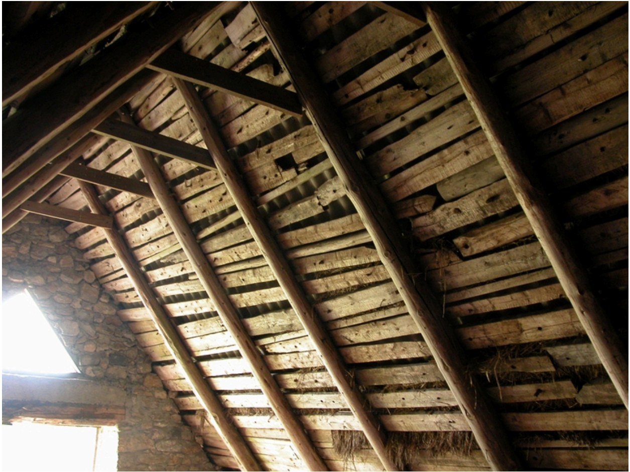
Vue intérieure de la charpente.
