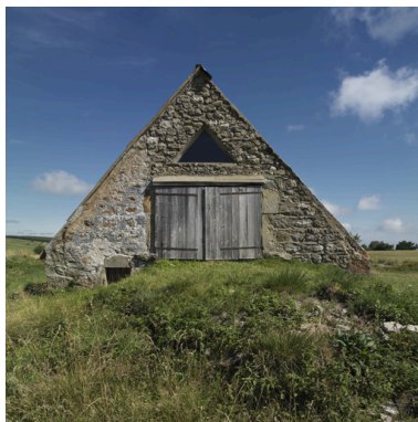
Vue du pignon sud. Phot. Eric Dessert IVR82_20064202048NUCA
