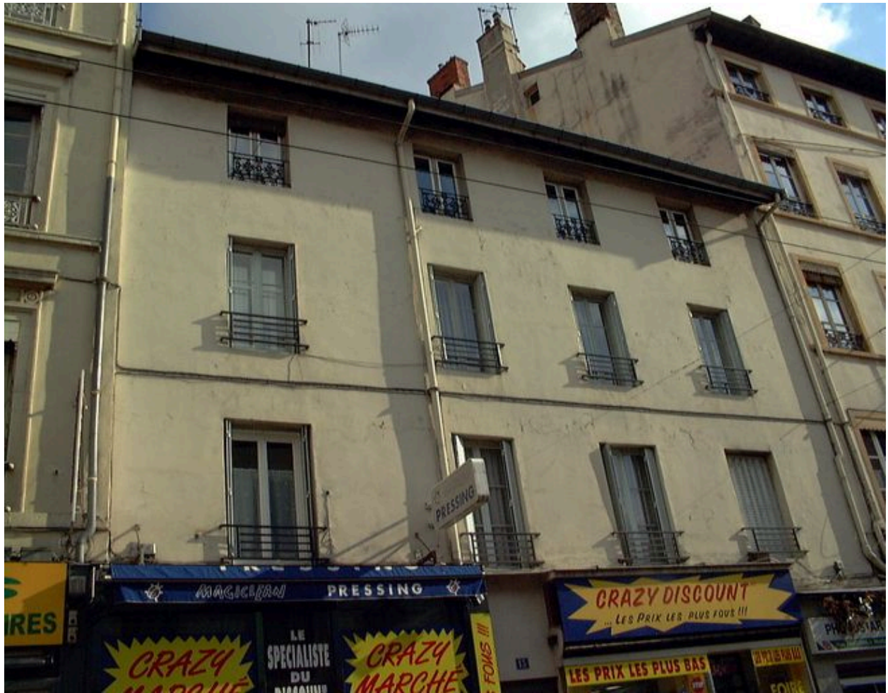
Elévation antérieure : détail des trois étages carrés
