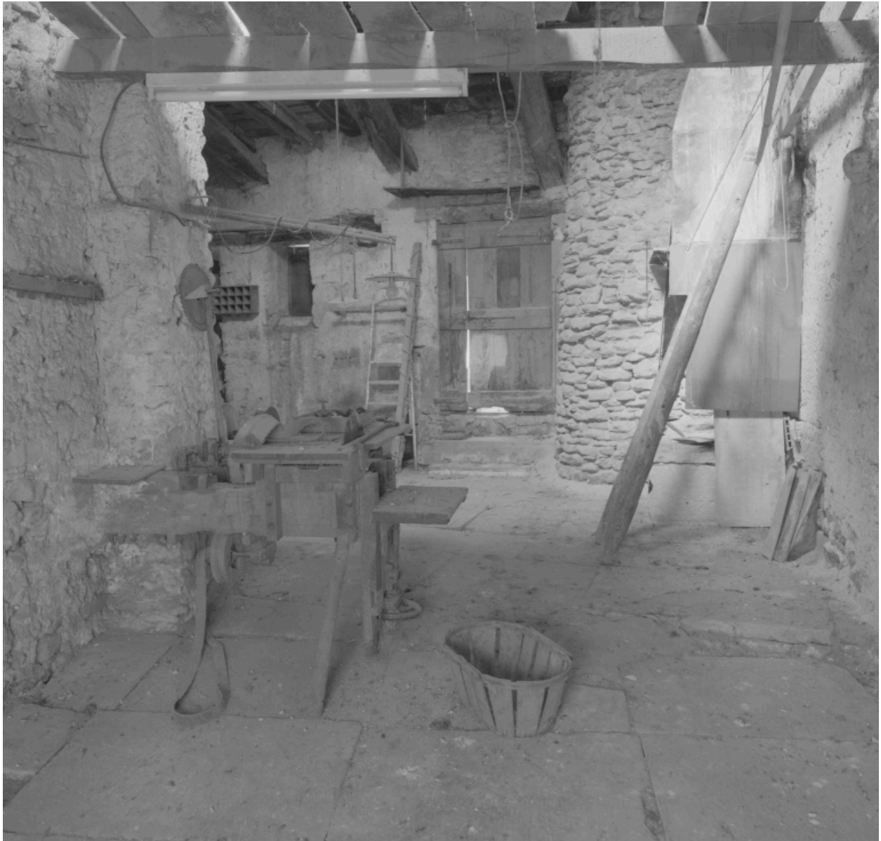
Village intra-muros, maison (AX 100), ancien atelier de menuiserie. Au premier plan, un établi.
