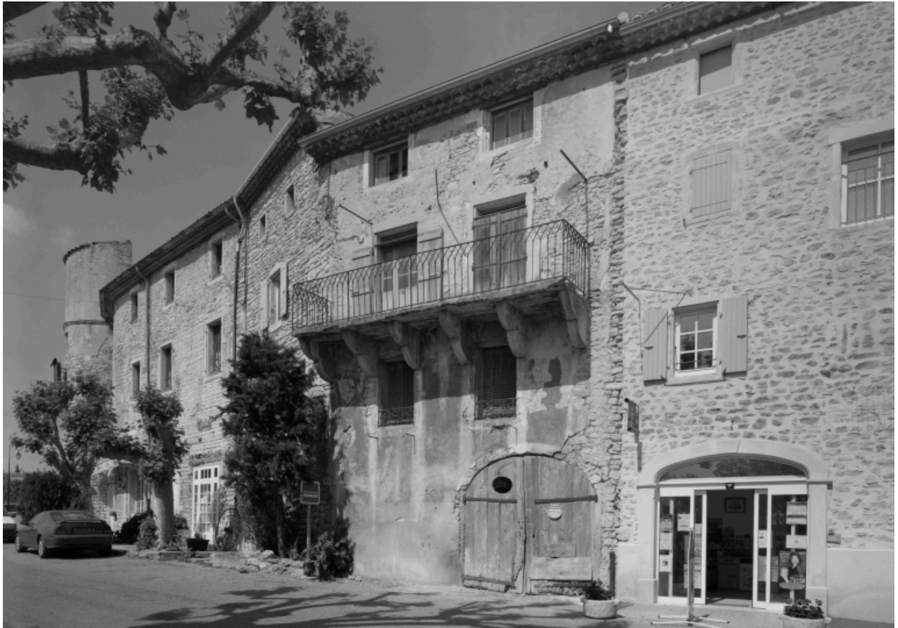
Place du 11 Novembre : ensemble de maisons adossées aux murailles de fortification et l'une des onze tours.
