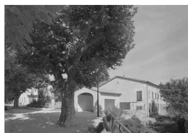
Place de la République. Vue de trois quarts d'un ancien moulinage installé le long du canal de la Rialhe. Phot. Eric Dessert IVR82_20002600921P
