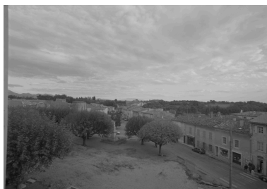
La Place du 11 Novembre, en cours de réaménagement. Vue depuis le 2e étage de la mairie. Phot. Eric Dessert IVR82_20002600919P
