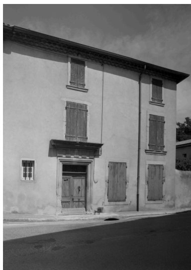
Ancien chemin de Taulignan à Valréas : un ancien moulinage, où toutes les machines sont encore conservées à l'intérieur. Phot. Eric Dessert IVR82_20002601146P
