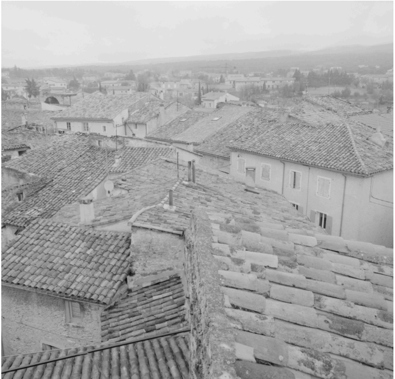
Vue des toits des maisons situées dans le quartier nord, rue des Fontaines.
