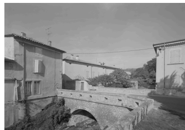
Ancien chemin de Taulignan à Valréas, pont sur la Rialhe reconstruit en 1913 sur des substructions plus anciennes. Phot. Eric Dessert IVR82_20002600916P
