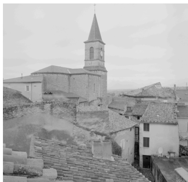
Vue de l'église, côté nord- est, et des toits des maisons. Phot. Eric Dessert IVR82_20012600121X
