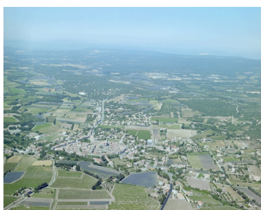
Vue aérienne rapprochée, prise du sud-est. Phot. Alain Franchella IVR82_20002601269XE
