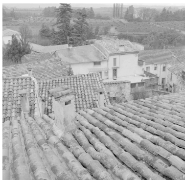
Vue des toits des maisons situées dans le quartier nord-est, rue des Fontaines. Phot. Eric Dessert IVR82_20012600117X
