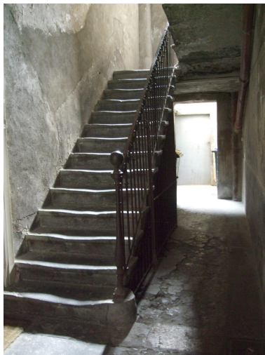
Escalier à vide central Phot. Nadine Halitim-Dubois IVR84_20186901272NUCA
