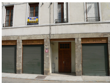
Rez-de-chaussée Phot. Isabelle Dupuis IVR82_20093800446NUCA
