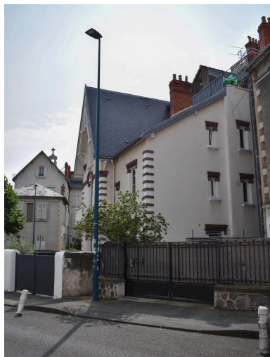
Elévation ouest sur la rue de Thiers Phot. Félicie Fougère IVR84_20246300036NUCA
