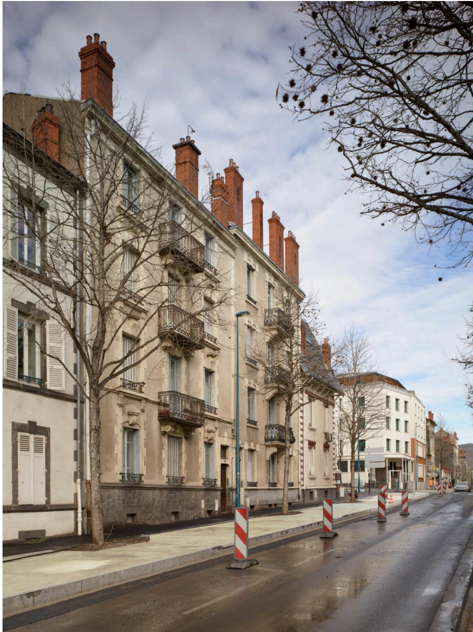
Façade sur l'avenue d'Italie
