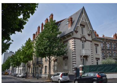
Angle sur l'avenue d'Italie du 52 avenue d'Italie Phot. Félicie Fougère IVR84_20246300040NUCA
