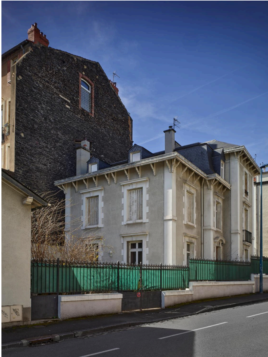
Elévation vue depuis la rue d'Ambert du 41 avenue d'Italie
