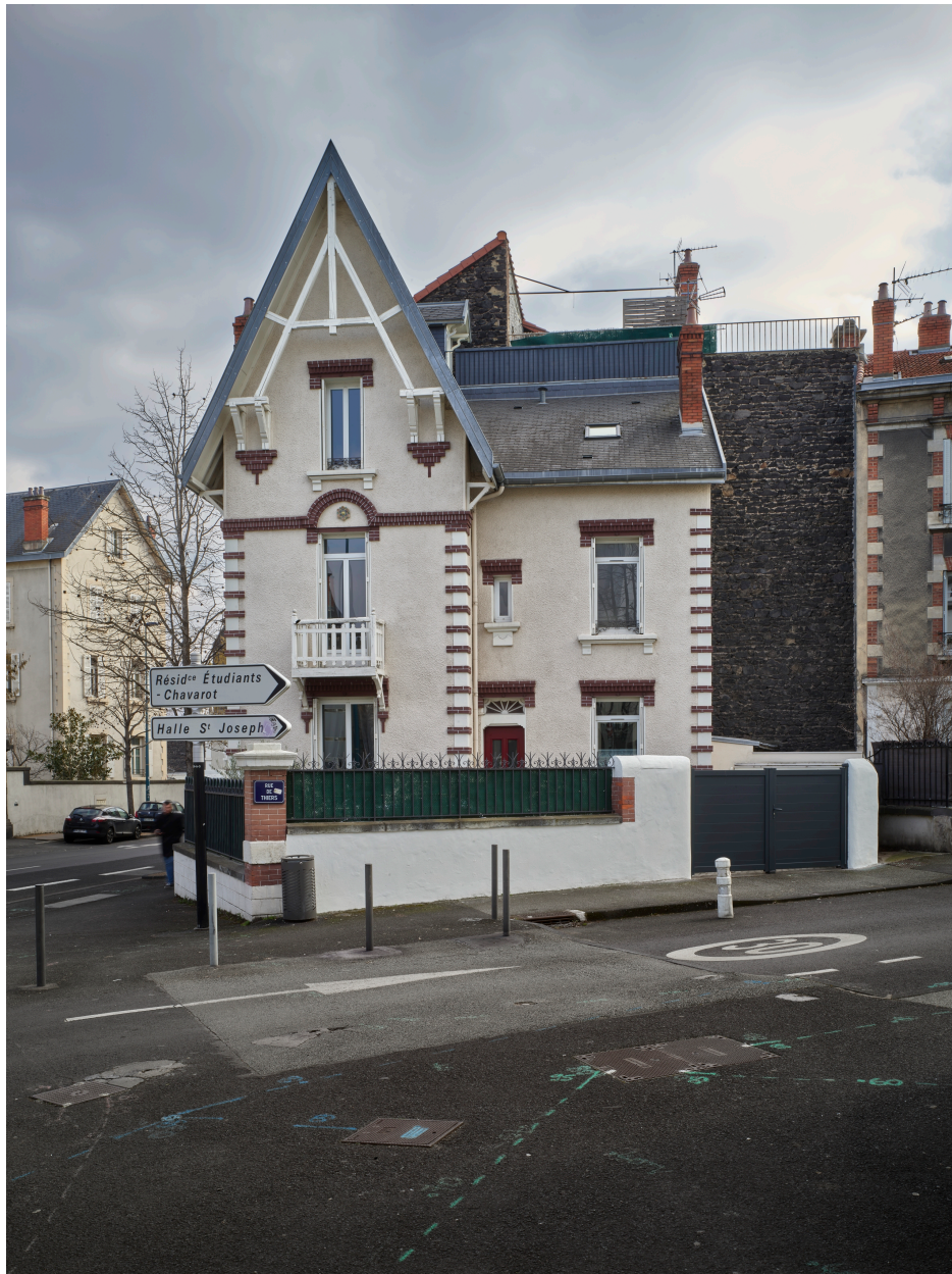
Elévation principale (donnant sur la rue de Thiers) du n°52 avenue d'Italie
