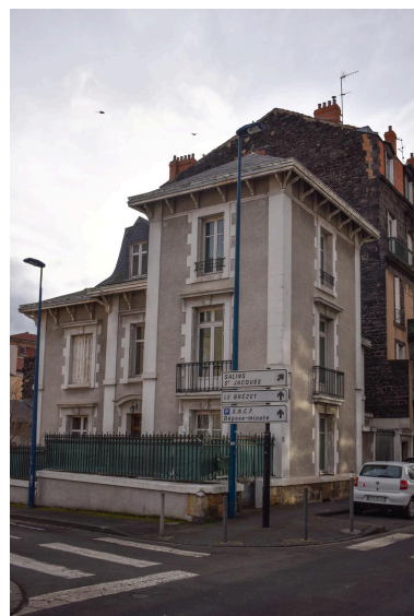
Façade sur la rue d'Ambert du 41 avenue d'Italie Phot. Félicie Fougère IVR84_20246300091NUCA
