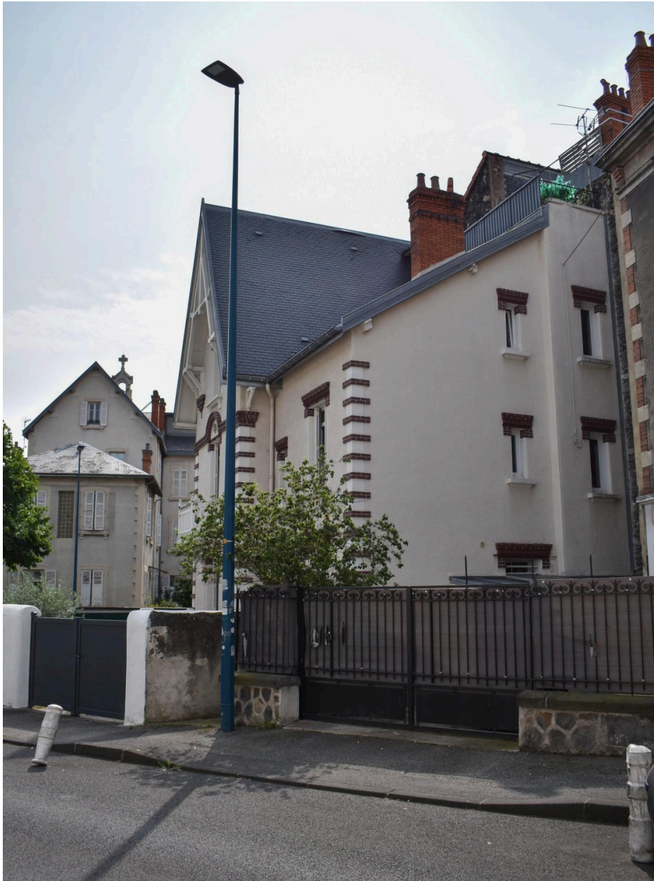
Elévation ouest sur la rue de Thiers
