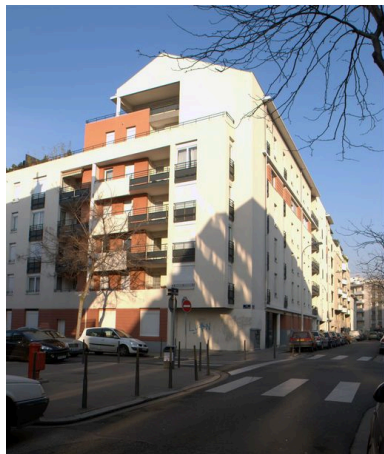
Vue générale depuis le sud-est Phot. Maryannick Chalabi IVR82_20116904023NUCA
