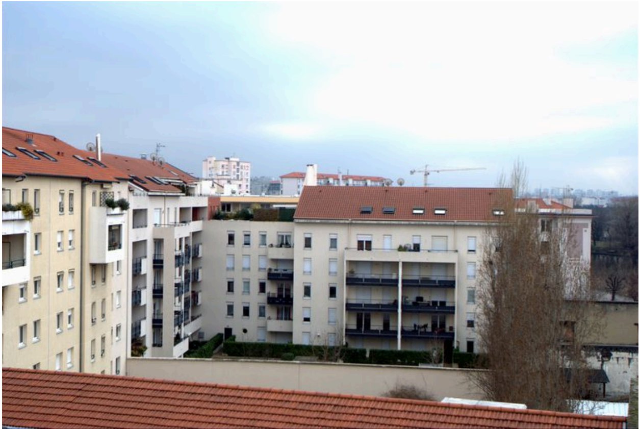
Élévation latérale postérieure, vue d'ensemble depuis l'ouest
