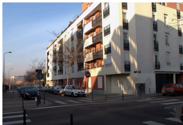
Elévation rue Docteur-Crestin Phot. Maryannick Chalabi IVR82_20116904024NUC
