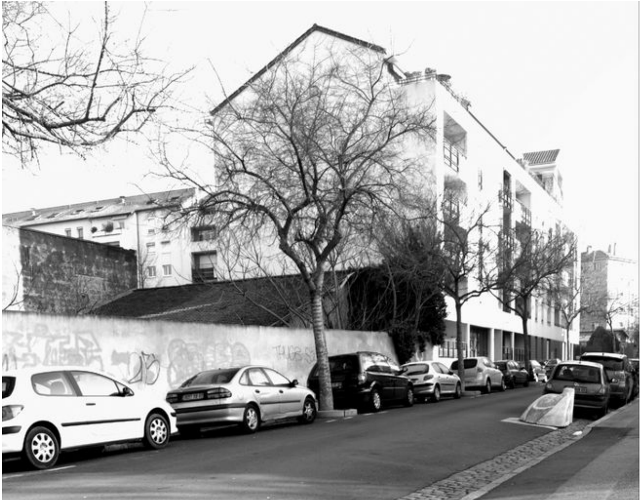
Elévation rue Docteur-Crestin depuis l'ouest
