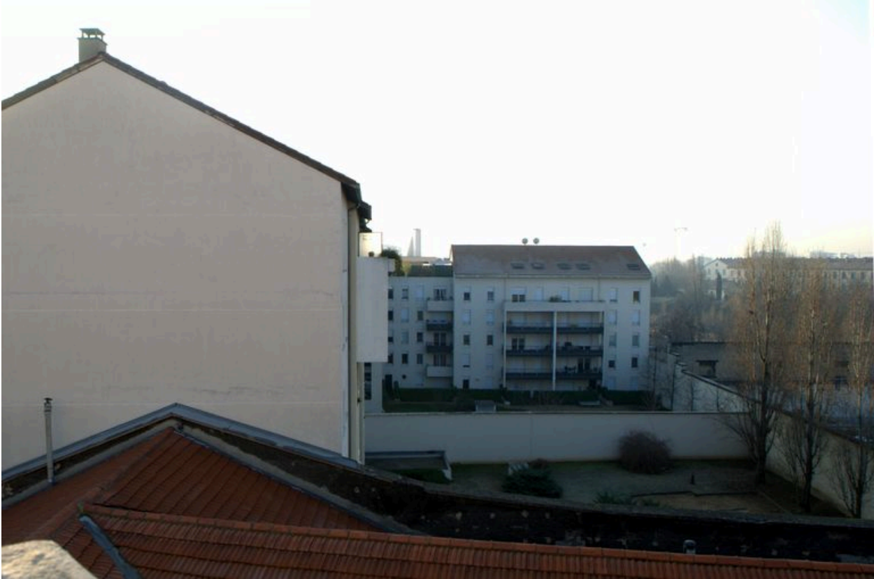
Élévation latérale postérieure, vue partielle depuis l'ouest
