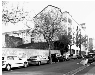
Elévation rue Docteur-Crestin depuis l'ouest Phot. Maryannick Chalabi IVR82_20116904025NUC
