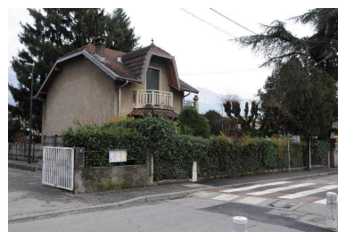
Vue d'ensemble Phot. Denys Harreau IVR82_20147300327NUCA
