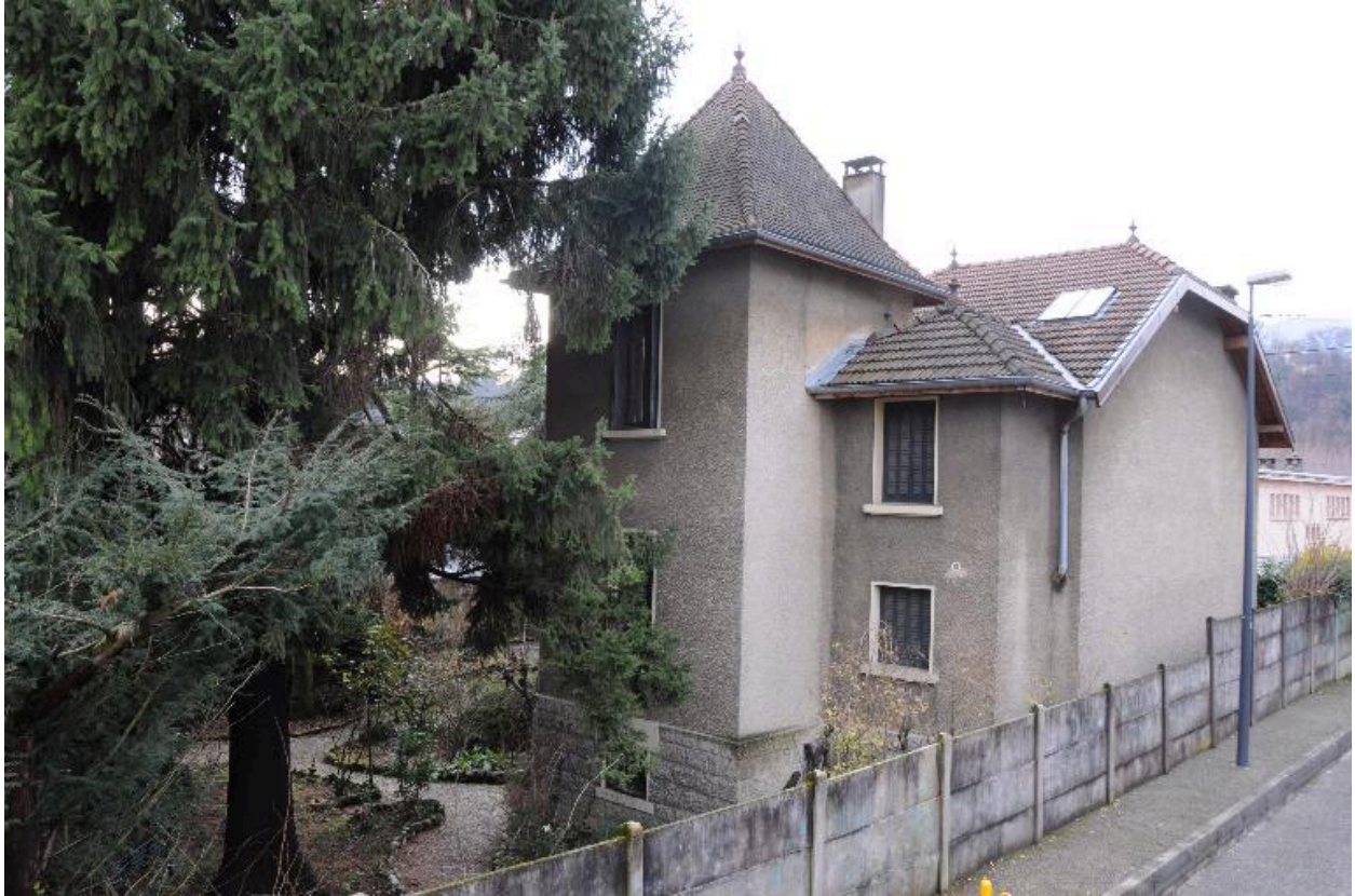
Vue depuis l'arrière
