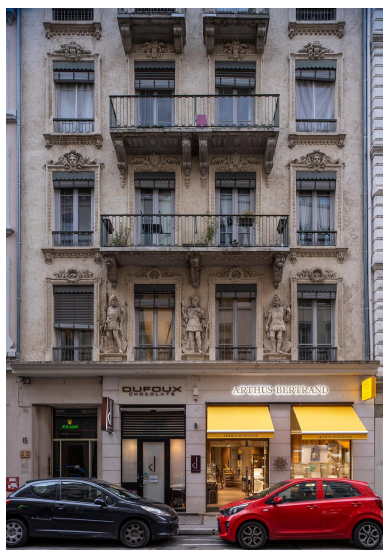
Vue de situation Phot. Michel Pérès IVR84_20236900567NUCA
