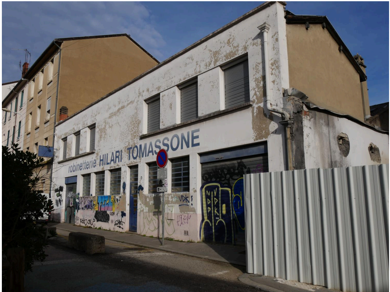
Vue d'ensemble robinetterie
