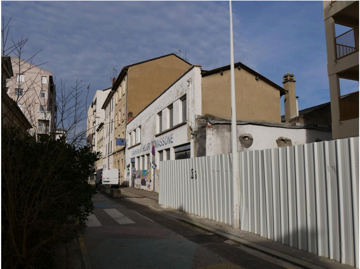
Vue d'ensemble robinetterie
