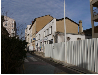
Vue d'ensemble robinetterie Phot. Nadine Halitim-Dubois IVR84_20246900038NUCA
