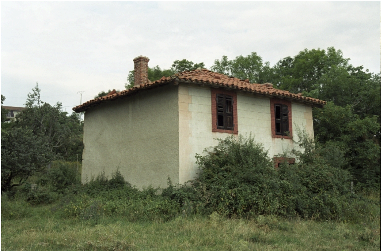
Maison isolée au lieu-dit Chez Pierroud (ZA 111), vue générale.
