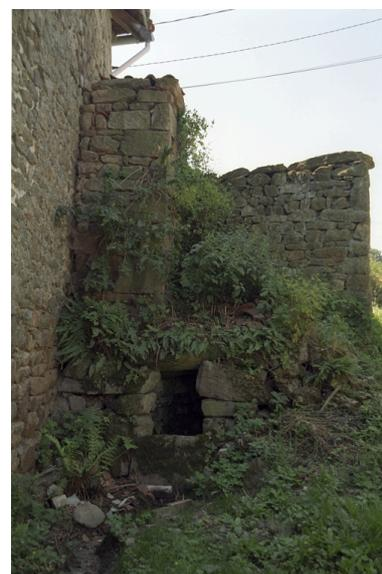
Ferme à la Bruyère (B3 810), Détail d'un ancien four dressé au-dessus d'un puits.
