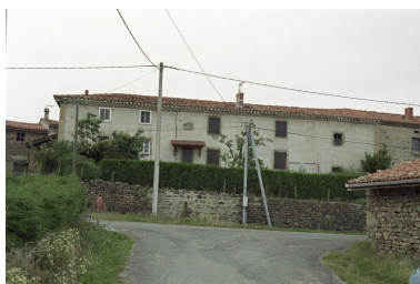
Ferme au lieu-dit Eculieux (B4 1003), vue générale. Phot. Thierry Monnet, Phot. Caroline Guibaud IVR82_20044201926ZE
