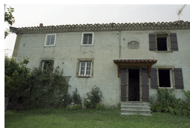
Ferme au lieu-dit Eculieux (B4 1003), vue générale de la façade du logis. Phot. Thierry Monnet, Phot. Caroline Guibaud IVR82_20044201924ZE
