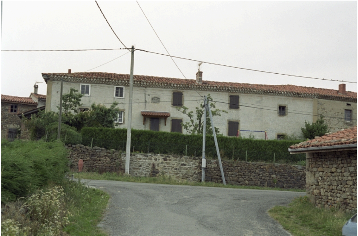
Ferme au lieu-dit Eculieux (B4 1003), vue générale.
