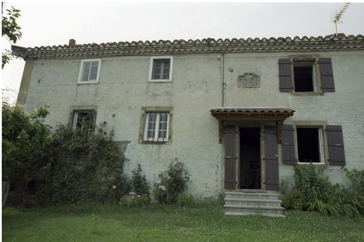
Ferme au lieu-dit Eculieux (B4 1003), vue générale de la façade du logis.
