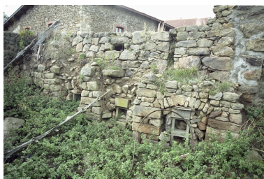
Ferme à Eculieux (B4 986), vue partielle de l'intérieur de l'étable en ruine. Phot. Thierry Monnet, Phot. Caroline Guibaud IVR82_20044201932ZE
