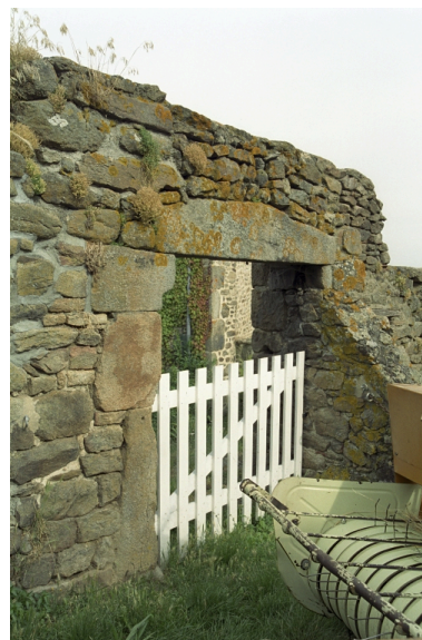
Ferme à Eculieux (B4 986), détail d'un portail. Phot. Thierry Monnet, Phot. Caroline Guibaud IVR82_20044201933ZE
