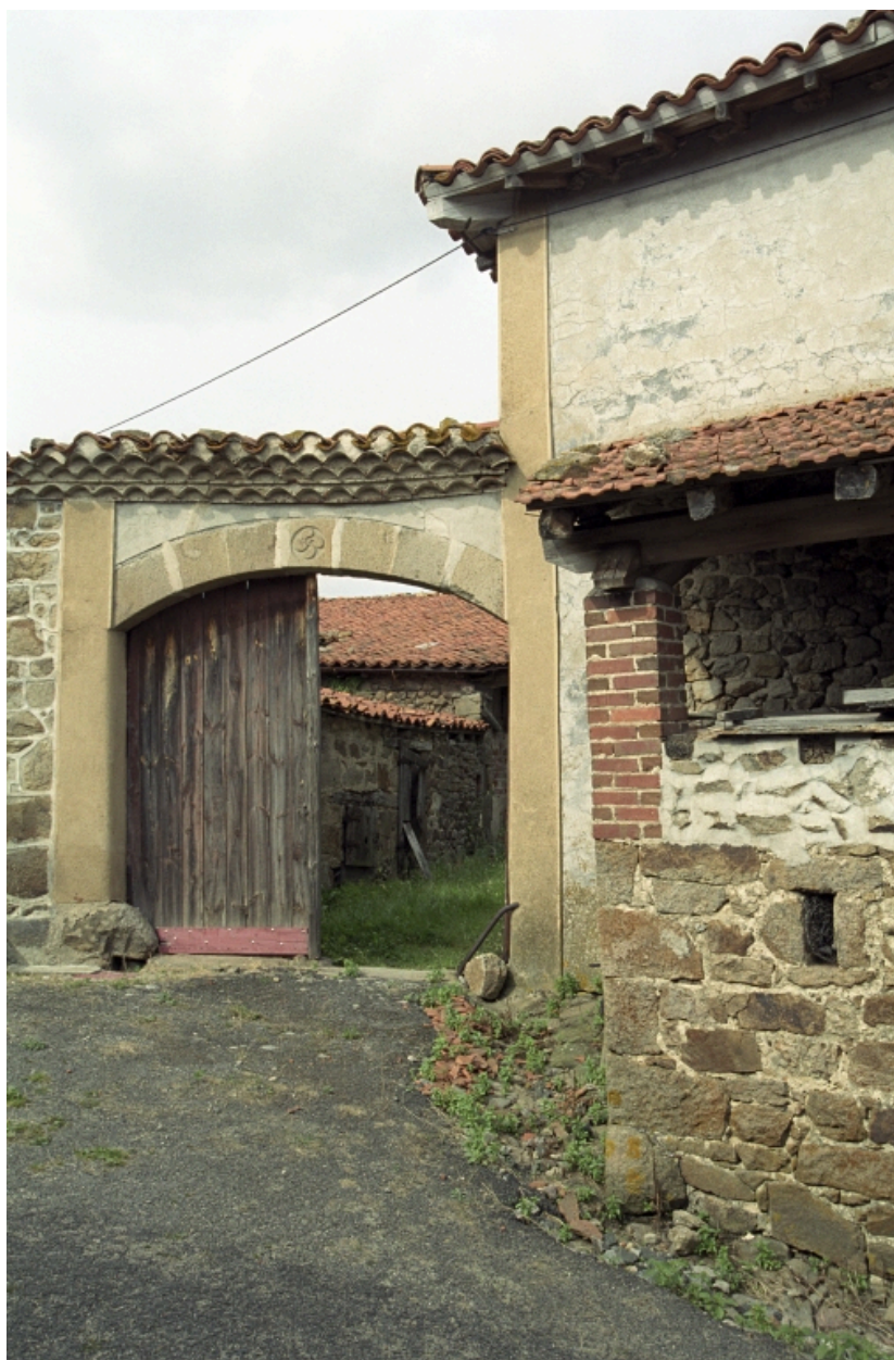
Ferme au lieu-dit Eculieux (B4 1003), détail de l'entrée de la cour arrière.
