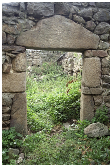
Ferme à Eculieux (B4 986), Détail d'un encadrement de baie daté 1712. Phot. Thierry Monnet, Phot. Caroline Guibaud IVR82_20044201931ZE
