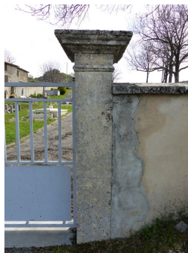
Pilier du portail. Phot. Alexeï Laurent IVR84_20162600253NUCA
