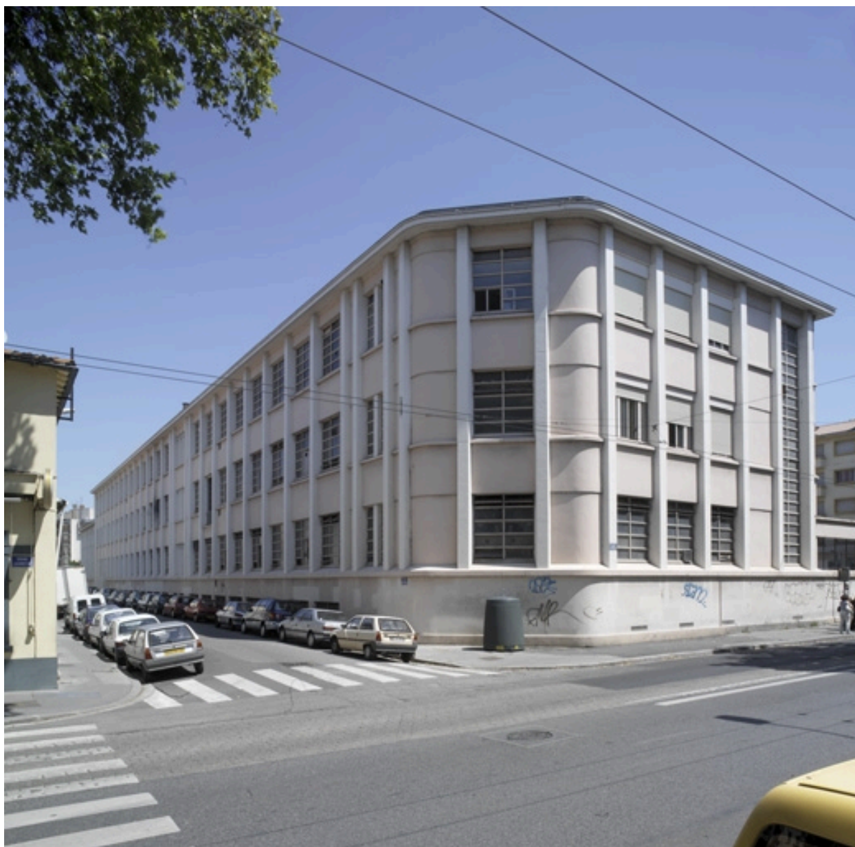
Vue sud-ouest des blanchisseries
