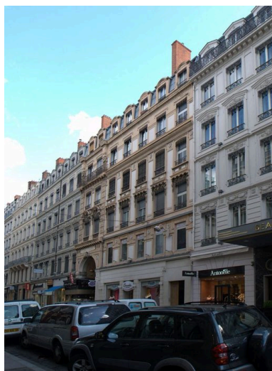
Vue d'ensemble des immeubles 69 et 71 rue du Pdt-Edouard- Herriot depuis le sud Phot. Catherine Guégan IVR82_20086903018NUCA
