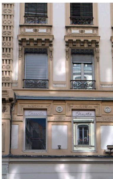
Elévation antérieure, détail des baies de l'entresol et du 1er étage Phot. Catherine Guégan IVR82_20086903026NUCA
