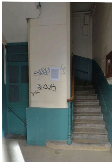
Vue de la première volée de l'escalier Phot. Catherine Guégan IVR82_20086903019NUCA
