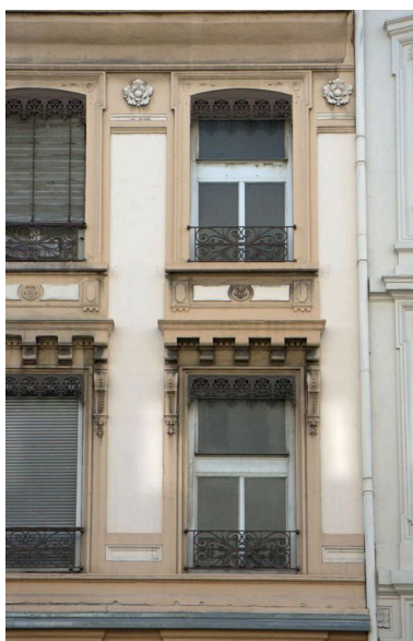
Elévation antérieure, détail des baies des 1er et 2e étages Phot. Catherine Guégan IVR82_20086903027NUCA
