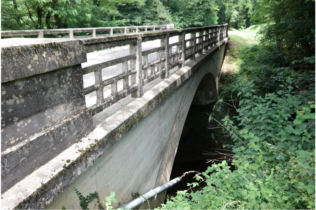
Pont du Parmand 2, vue de la face amont
