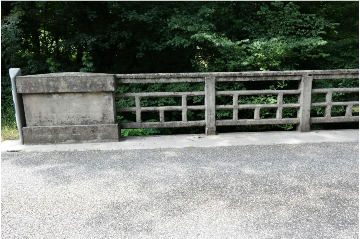
Pont du Parmand 2, détail des garde-corps
