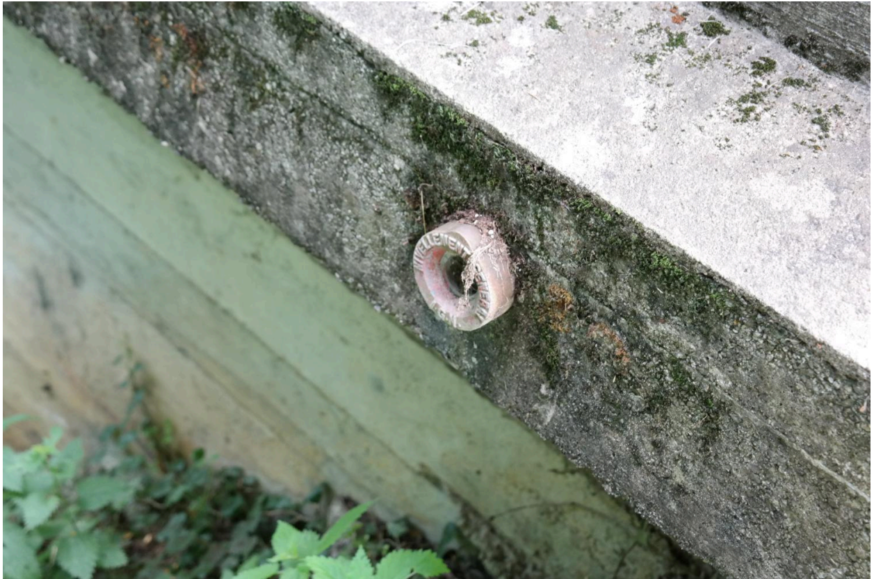
Pont du Parmand 2, détail d'une borne géodésique
