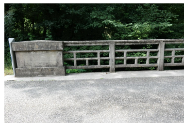
Pont du Parmand 2, détail des garde-corps Phot. Pascale Renard IVR84_20207403142NUCA
