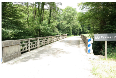
Pont du Parmand 2, vue de la chaussée Phot. Pascale Renard IVR84_20207403141NUCA
