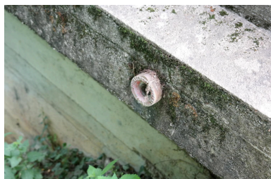
Pont du Parmand 2, détail d'une borne géodésique Phot. Pascale Renard IVR84_20207403140NUCA
