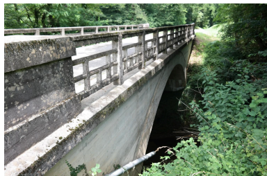
Pont du Parmand 2, vue de la face amont Phot. Pascale Renard IVR84_20207403137NUCA
