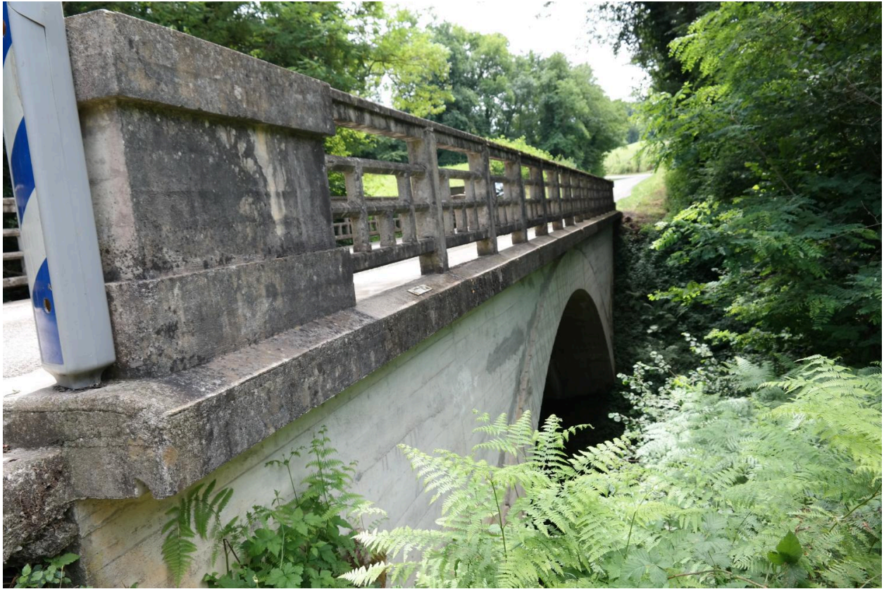
Pont du Parmand 2, vue de la face aval
