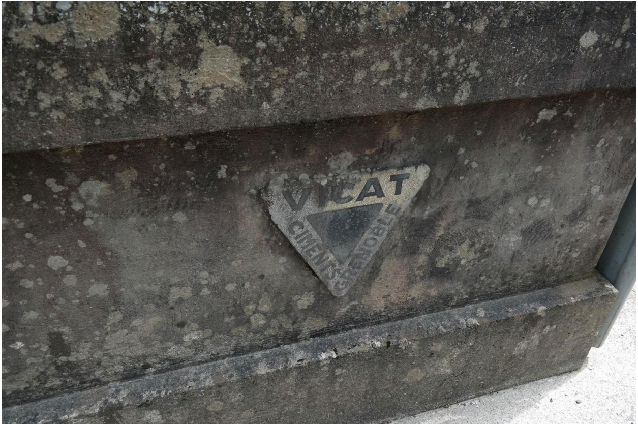
Pont du Parmand 2, détail d'une inscription sur garde-corps
