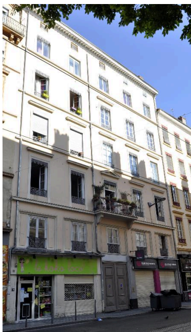
Immeuble sur rue, élévation antérieure Phot. Magali Delavenne IVR82_20156901240NUCA
