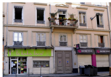
Immeuble sur rue, soubassement : premier étage en entresol, deuxième étage privilégié Phot. Magali Delavenne IVR82_20156901241NUCA
