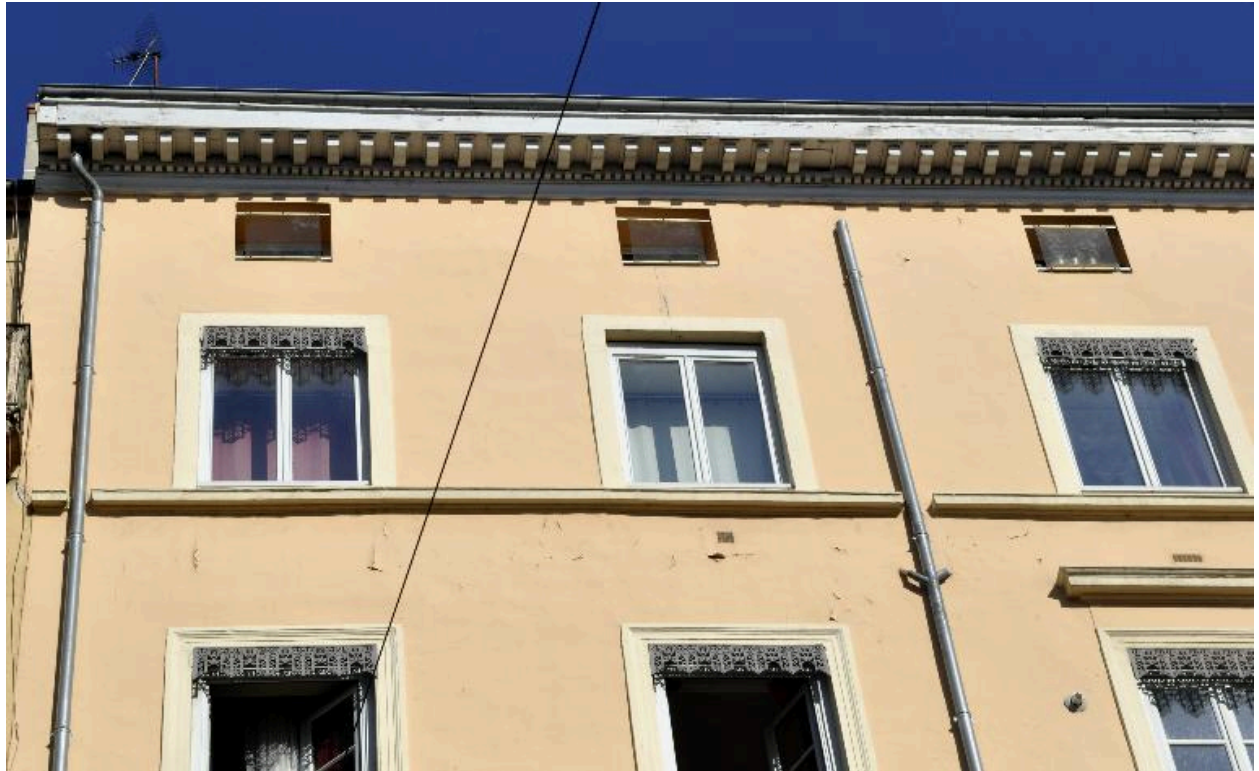
Immeuble sur rue, élévation antérieure : vue du dernier étage, de l'étage de comble et de la corniche
