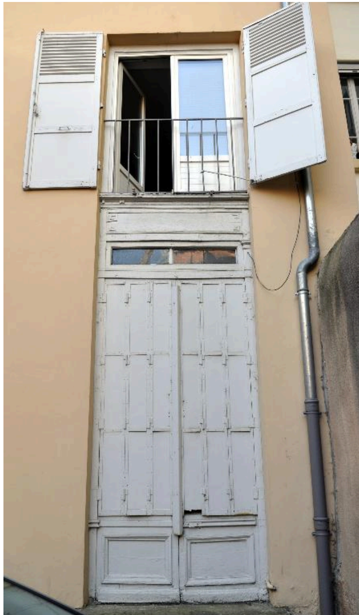
Immeuble sur rue, élévation postérieure : porte-fenêtre du rez-de-chaussée, menuiserie ancienne
