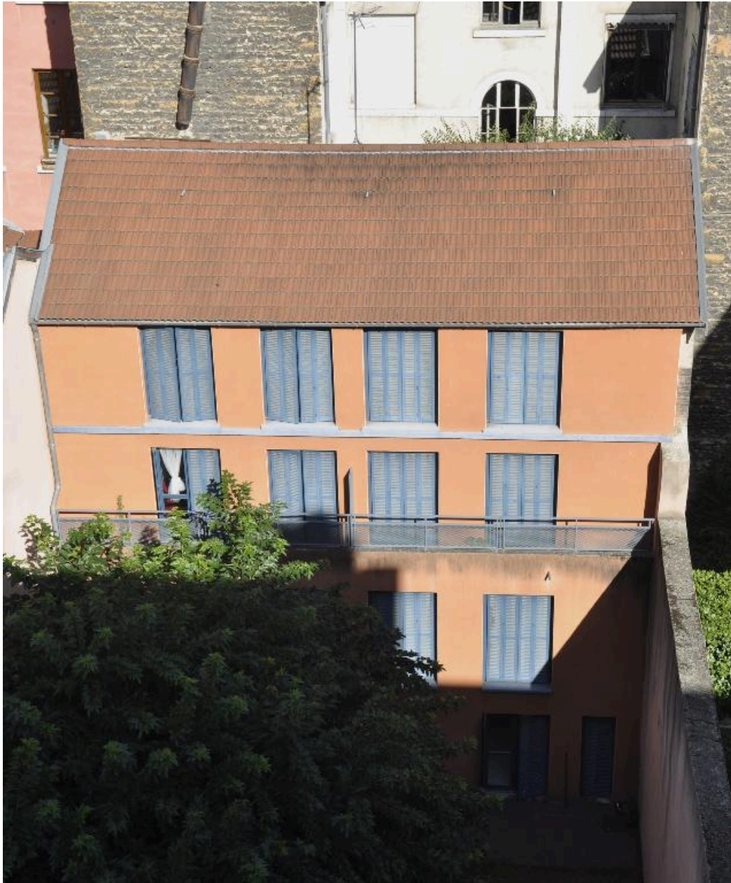
Immeuble en fond de cour, construit par surélévation d'un ancien entrepôt
