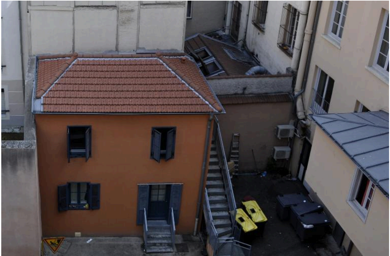
Maison dans la cour : toit à longs pans et croupes, construction en briques possible
