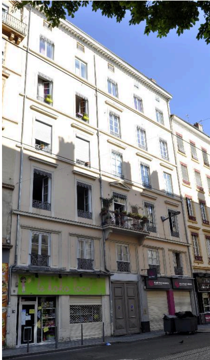
Immeuble sur rue, élévation antérieure
