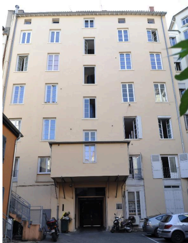
Immeuble sur rue, élévation postérieure, avec la loge de concierge en encorbellement Phot. Magali Delavenne IVR82_20156901247NUCA
