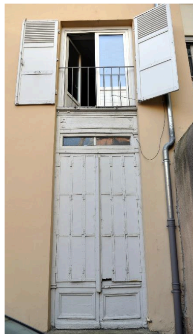
Immeuble sur rue, élévation postérieure : porte-fenêtre du rez- de-chaussée, menuiserie ancienne Phot. Magali Delavenne IVR82_20156901248NUCA
