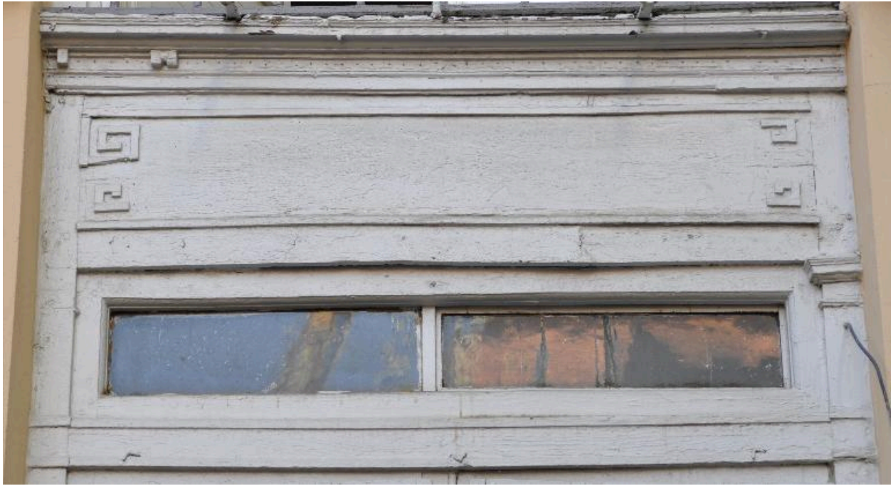
Immeuble sur rue, élévation postérieure : détail, imposte de la porte-fenêtre
