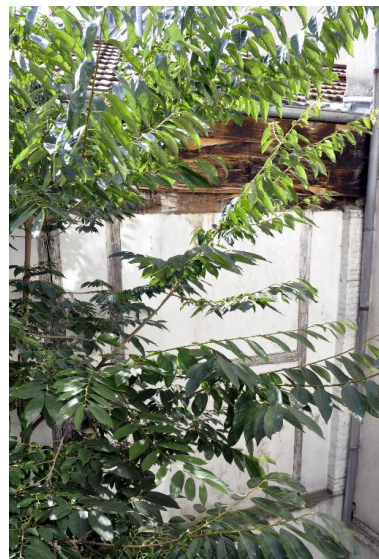
Immeuble en fond de cour, élévation postérieure : pan de bois visible en partie haute Phot. Magali Delavenne IVR82_20156901250NUCA
