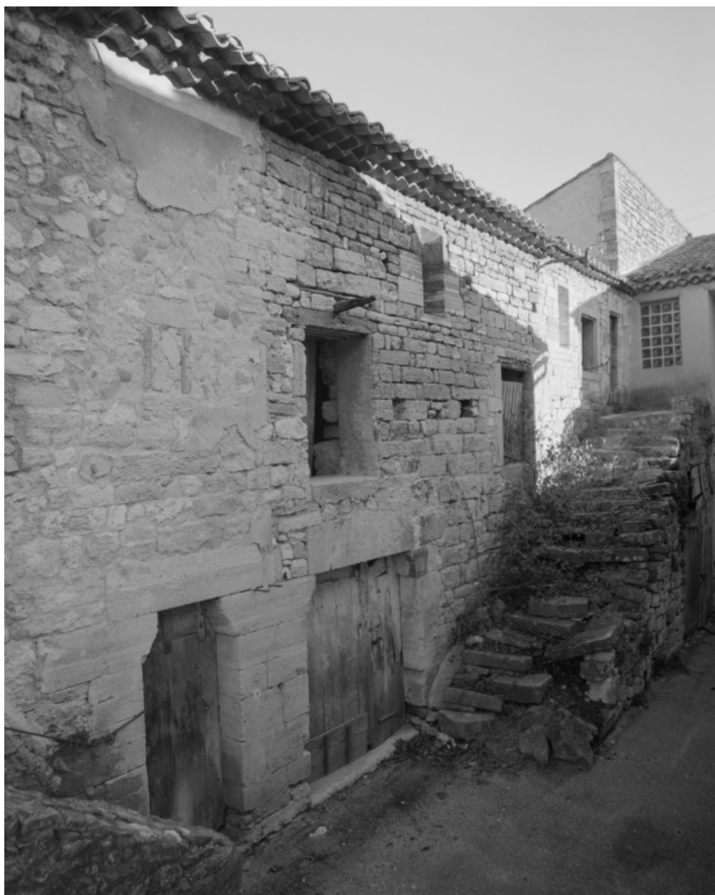
Vue partielle de la façade antérieure avant restauration (parc. A 149 et 150).
