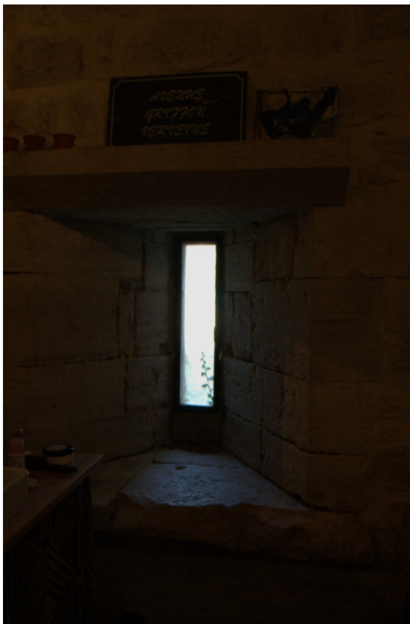
Vue intérieure, baie du rez-de-chaussée à ébrasement intérieur.
