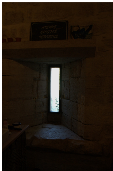
Vue intérieure, baie du rez-de- chaussée à ébrasement intérieur. Phot. Geneviève Jourdan IVR82_20102600472NUCA
