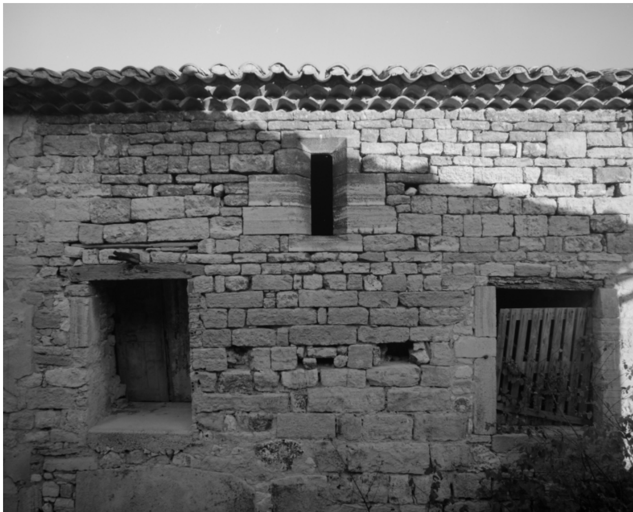
Détail d'ouvertures dont une fenêtre ancienne d'origine (A1 149).
