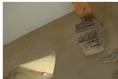
Vue intérieure, détail : console (en remploi) supportant une sablière. Phot. Geneviève Jourdan IVR82_20102600471NUCA
