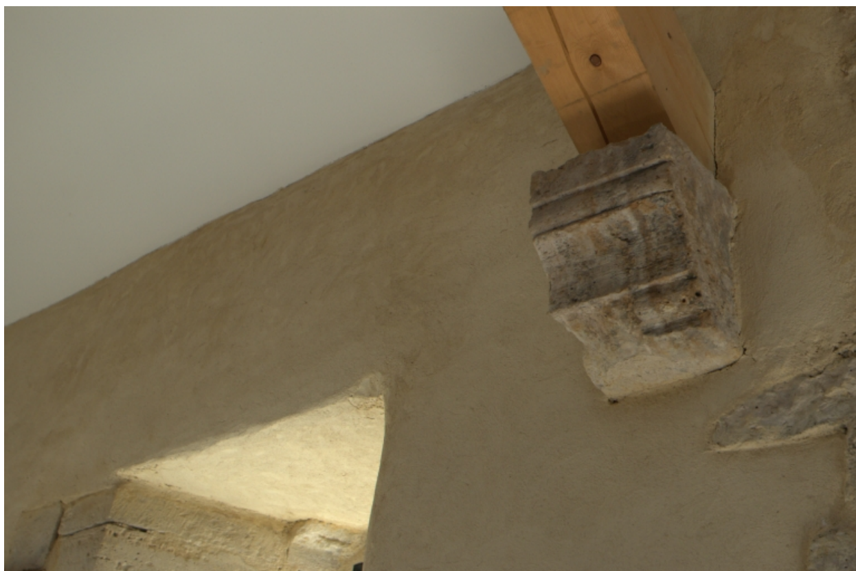
Vue intérieure, détail : console (en remploi) supportant une sablière.
