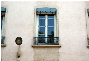
Elévation antérieure : détail de baie Phot. Véronique Belle IVR82_20076901025NUCA
