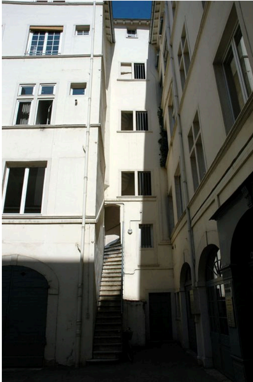
La cour : escalier desservant le côté ouest
