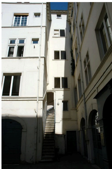
La cour : escalier desservant le côté ouest Phot. Véronique Belle IVR82_20066902673NUCA
