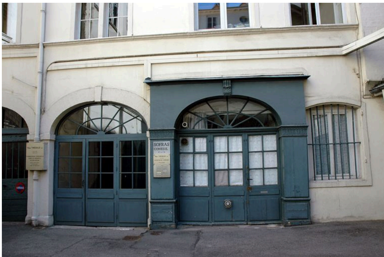
La cour : rez-de-chaussée de l'élévation nord
