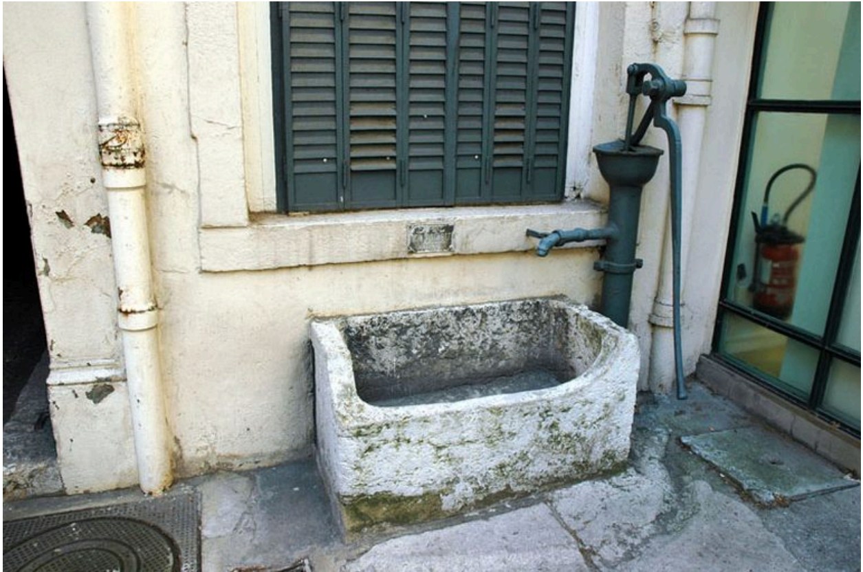
La cour, côté sud : pompe et bassin
