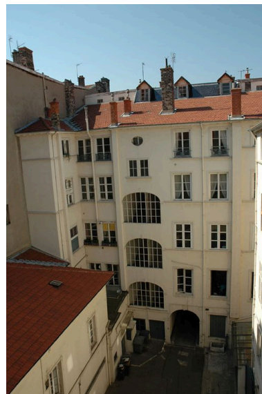
Elévation postérieure du bâtiment sur rue Phot. Véronique Belle IVR82_20076901028NUCA
