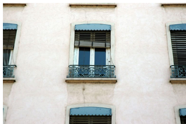
Elévation antérieure : détail Phot. Véronique Belle IVR82_20066902670NUCA
