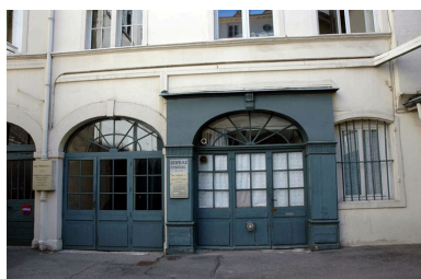
La cour : rez-de-chaussée de l'élévation nord Phot. Véronique Belle IVR82_20076901026NUCA
