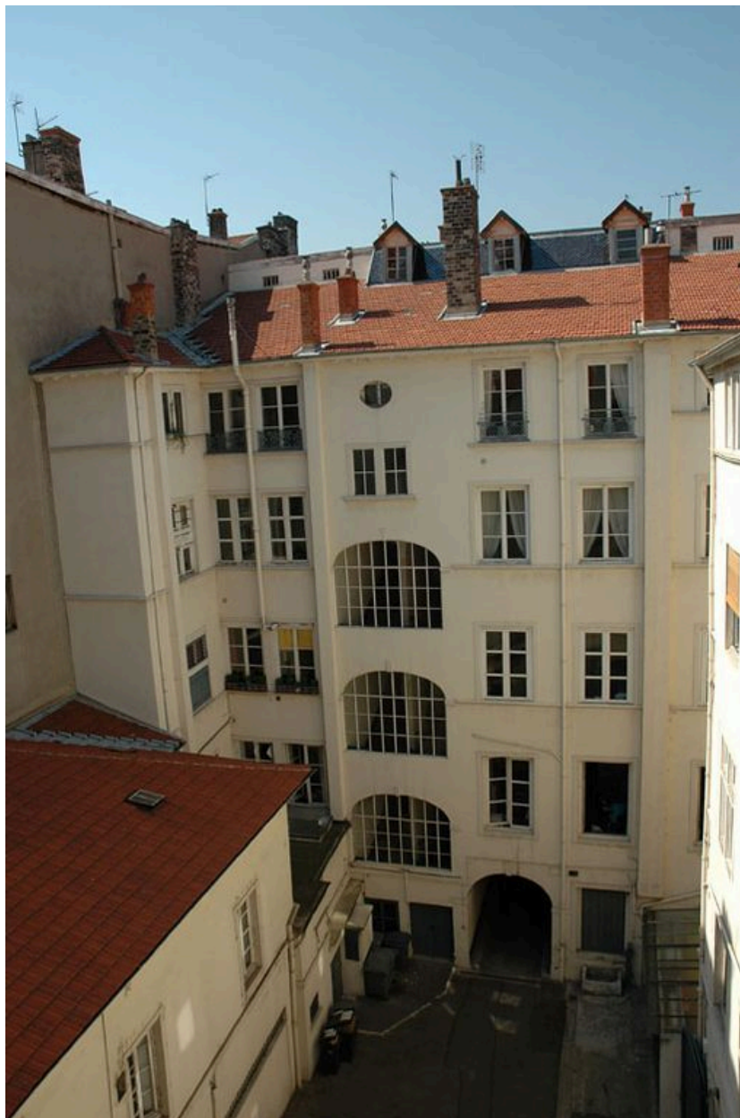
Elévation postérieure du bâtiment sur rue
