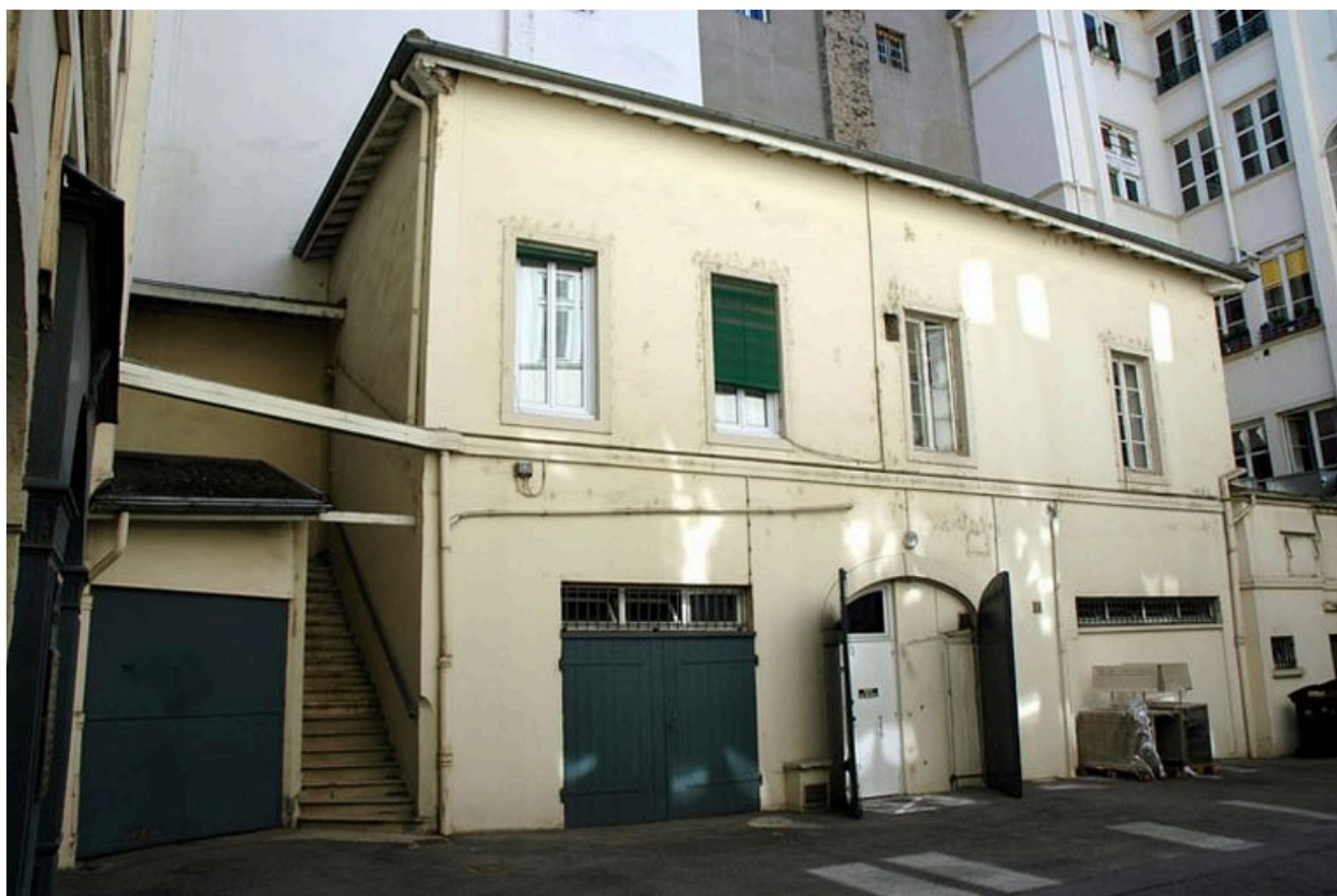
La cour : dépendances et escalier côté est
