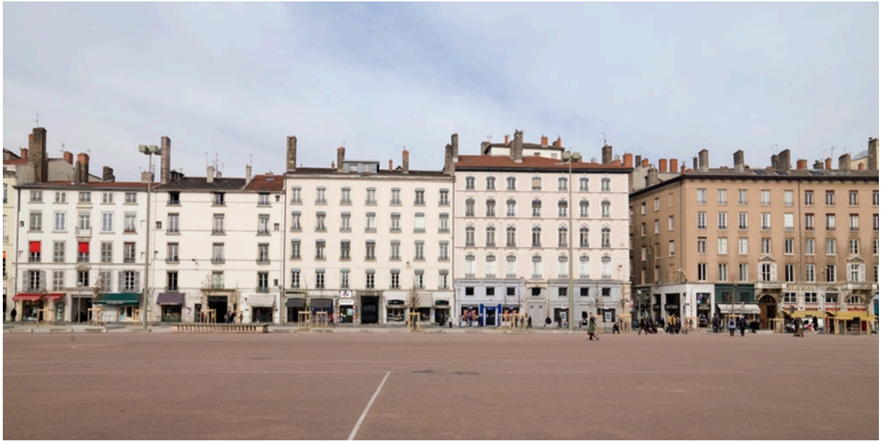
Vue de situation (3e immeuble à partir de la gauche) en 2009, après la coupe des platanes et la plantation de jeunes chênes chevelus
