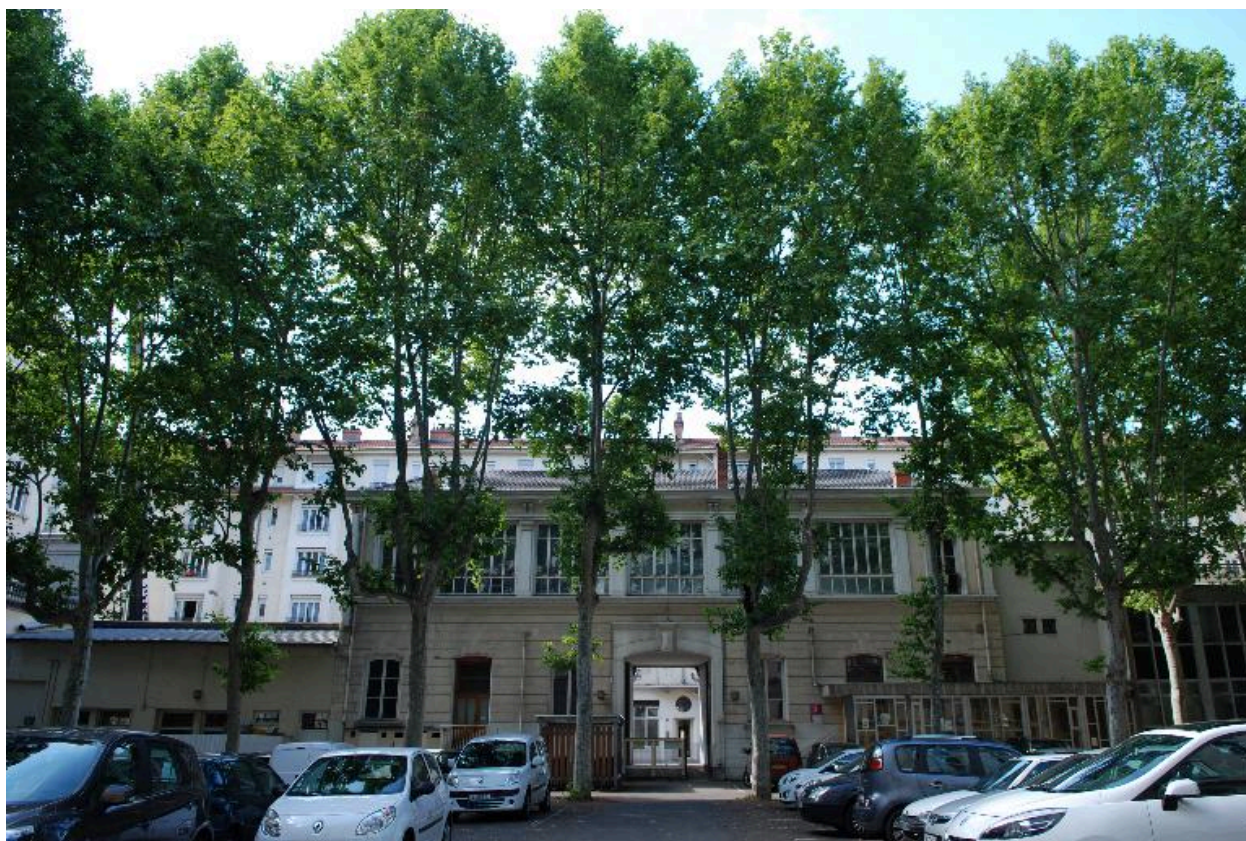
Vue du bâtiment rue Bossuet depuis la cour intérieure.
