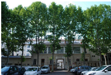
Vue du bâtiment rue Bossuet depuis la cour intérieure. Phot. Catherine Guillot IVR82_20136902648NUCA
