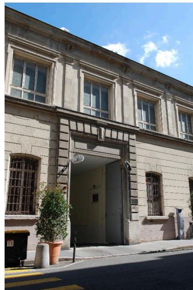
Détail du porche du bâtiment rue Bossuet. Phot. Catherine Guillot IVR82_20136902647NUCA
