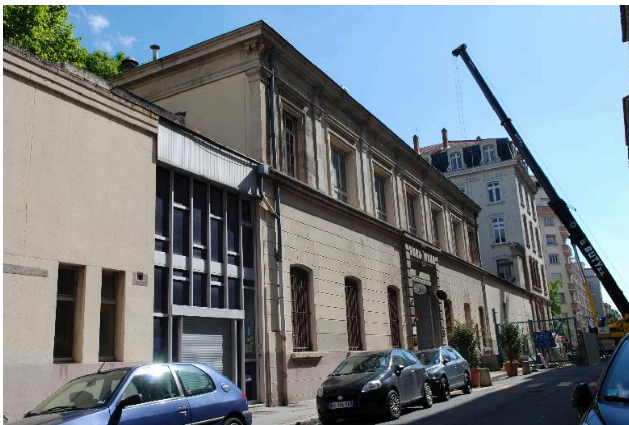
Vue du bâtiment rue Bossuet
