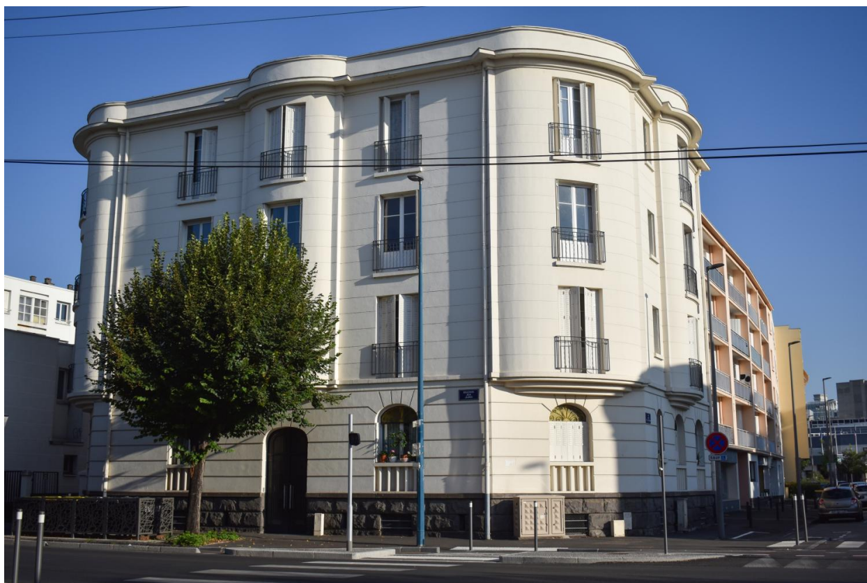
Façade sur le boulevard Jean-Jaurès
