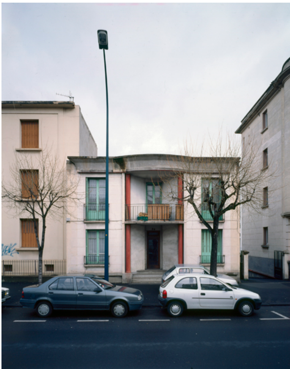
Immeuble voisin, n°24 bd Jean-Jaurès. Vue de la façade sur le boulevard
