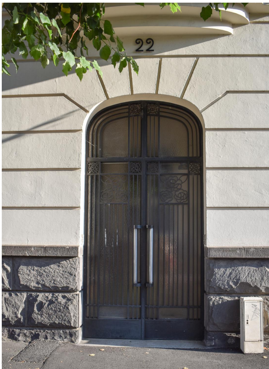
Porte d'entrée sur le boulevard
