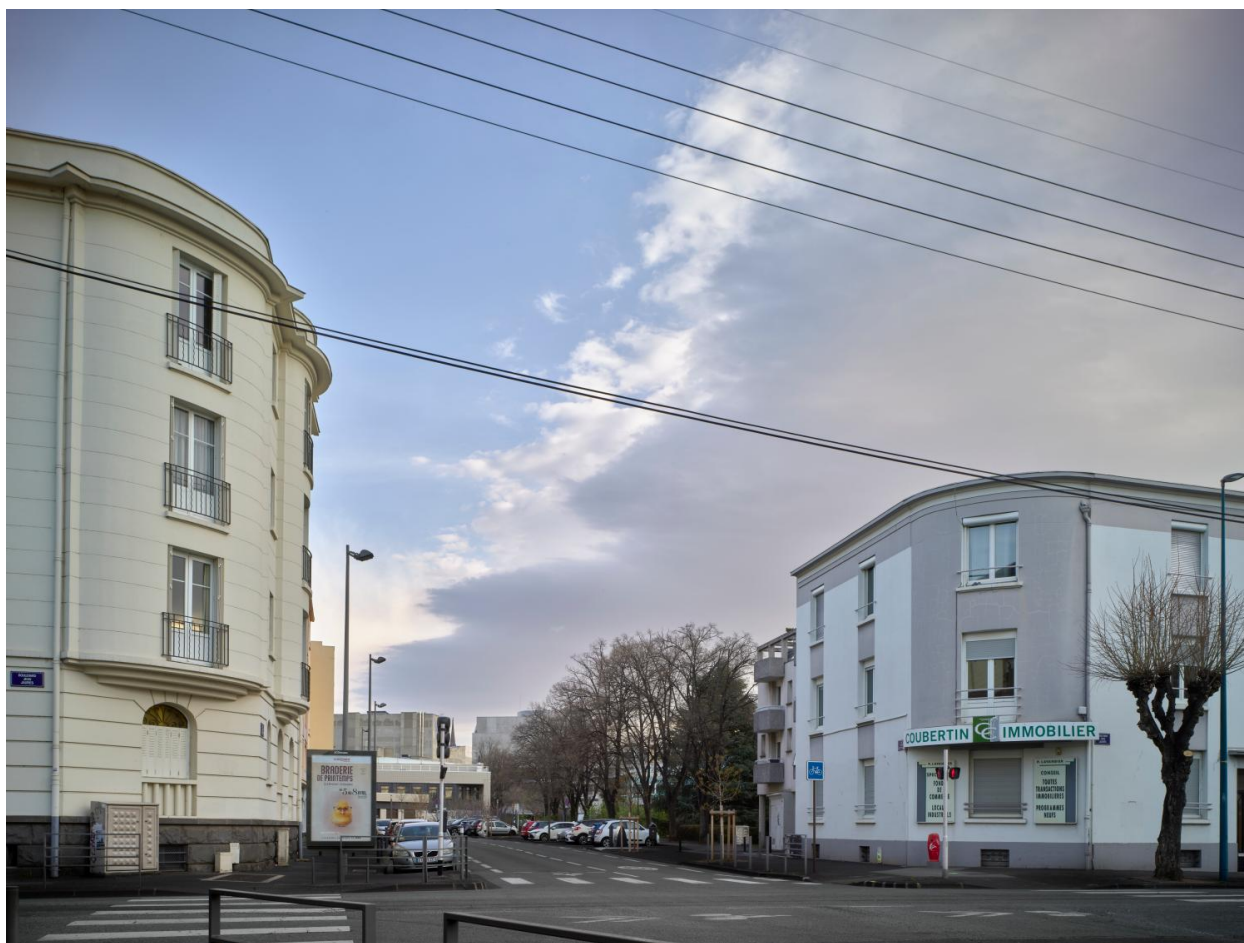
Angle de la rue Pierre-de-Coubertin et du boulevard Jean-Jaurès
