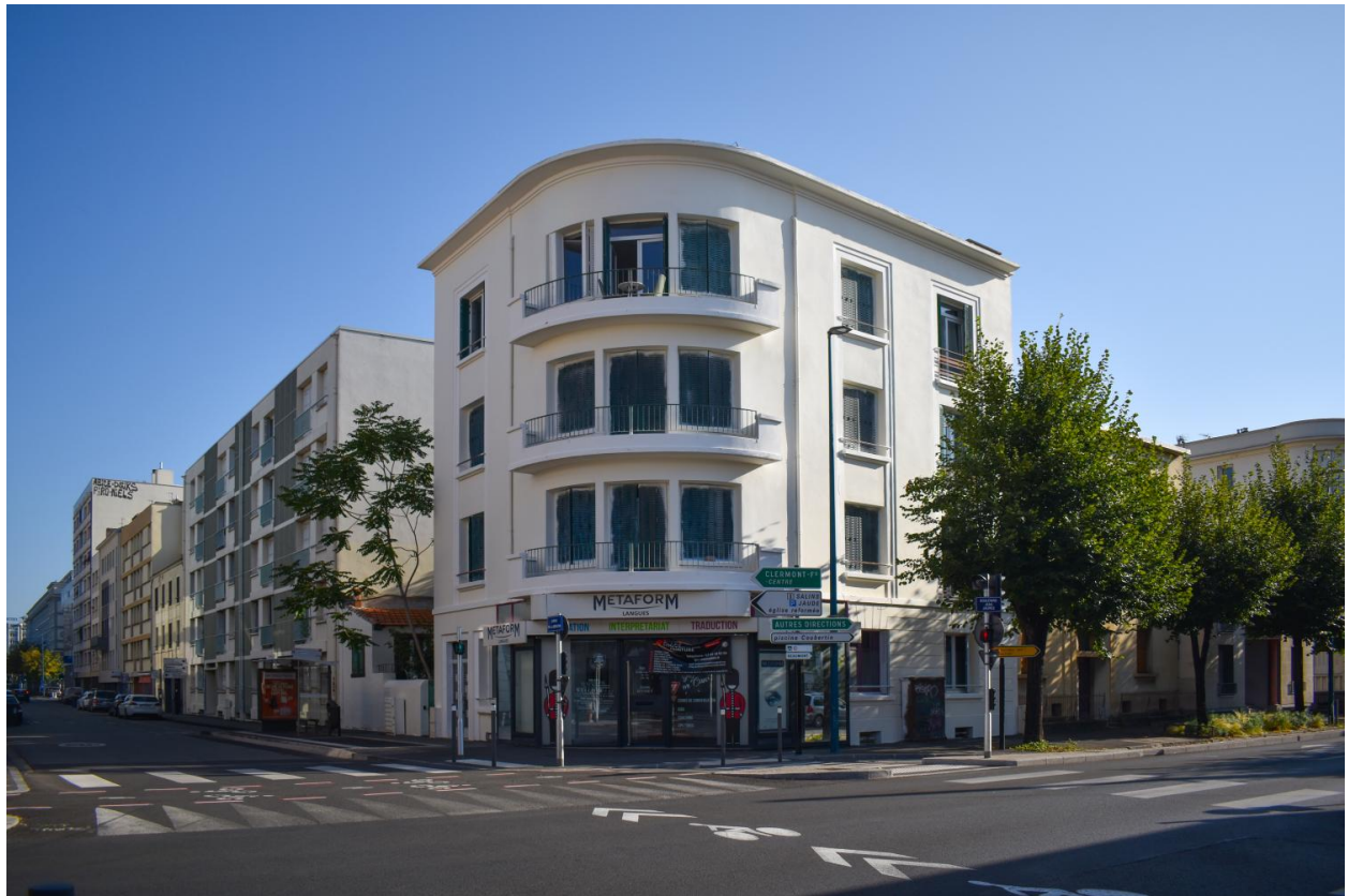
Façade d'angle, carrefour avenue de la Libération et boulevard Jean-Jaurès
