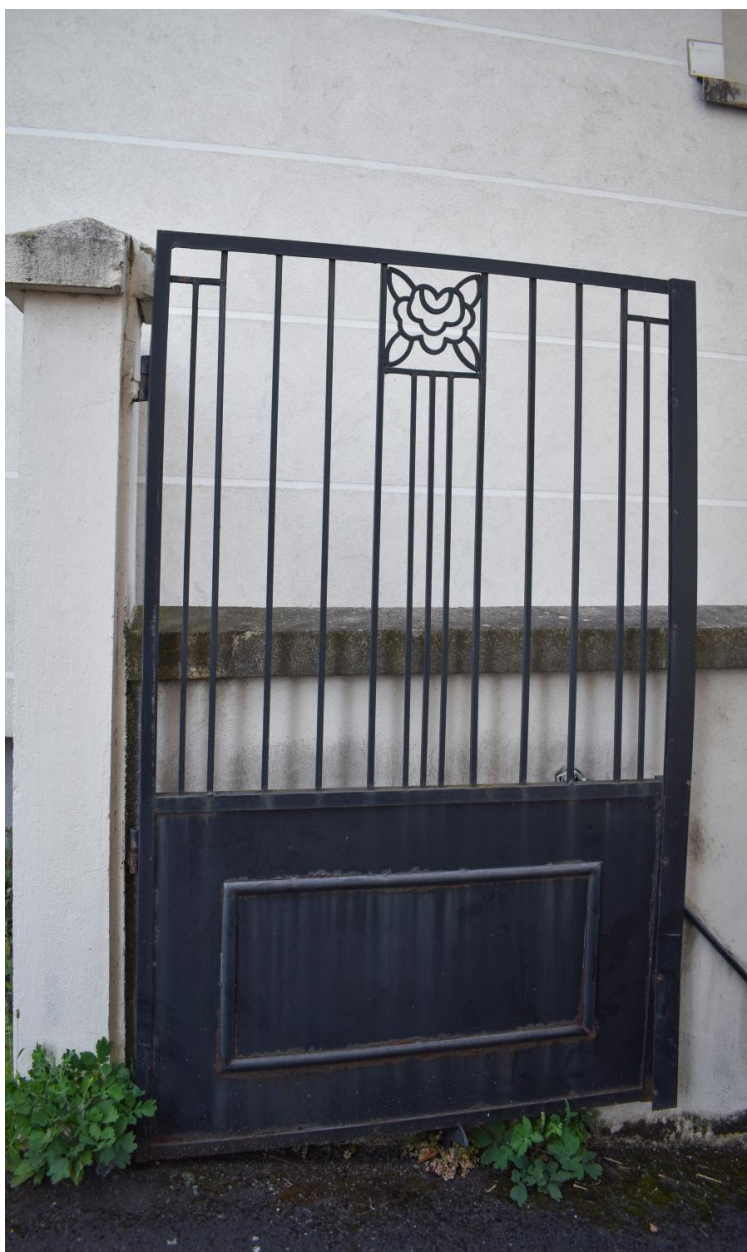
Portail de l'allée de desserte de la cour arrière
