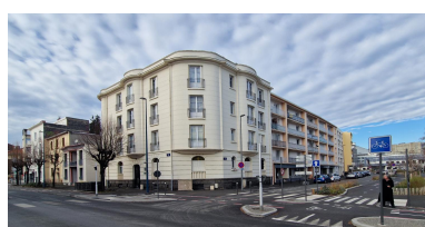
Carrefour du boulevard Jean-Jaurès et de la rue Pierre-de-Coubertin Phot. François-Nicolas L'Hardy IVR84_20256300213NUCA
