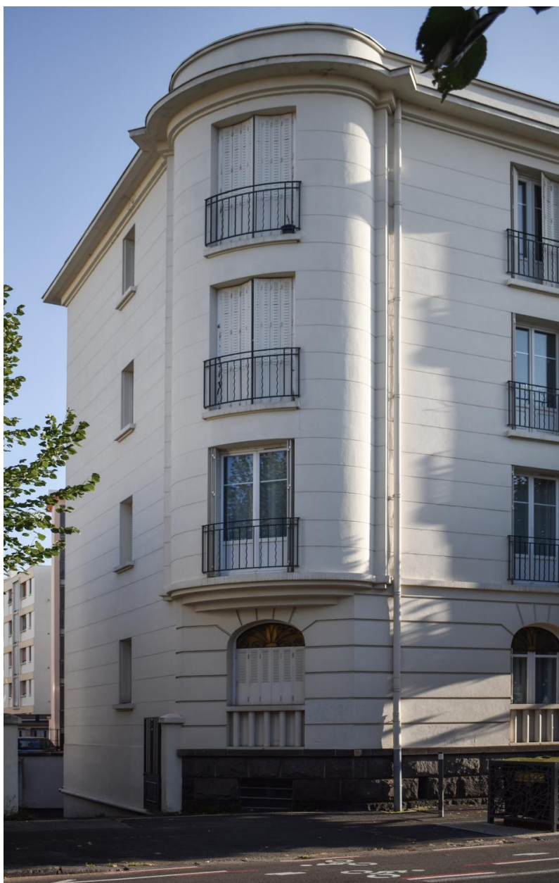
Travée d'angle sur l'allée de desserte de la cour arrière
