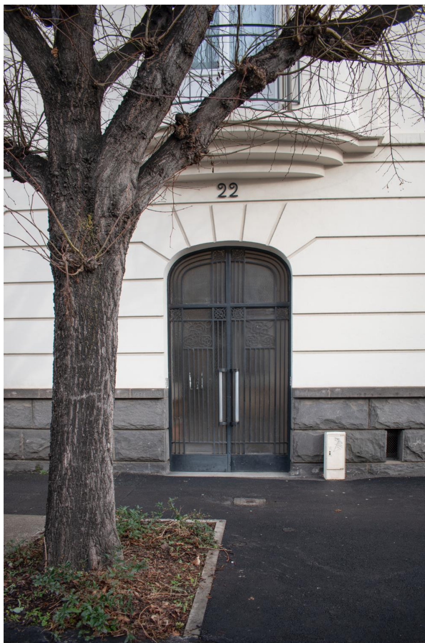
Porte d'entrée sur le boulevard
