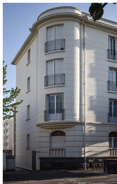
Travée d'angle sur l'allée de desserte de la cour arrière Phot. Félicie Fougère IVR84_20246302096NUCA
