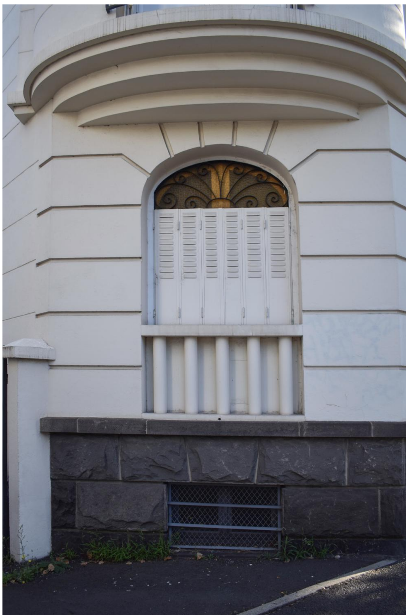
Baie du rez-de-chaussée d'une travée d'angle
