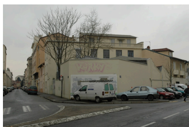
Vue générale du site, angle sud ouest. Phot. Nadine Halitim-Dubois IVR82_20096901657NUCA
