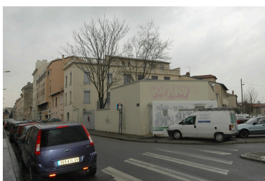
Vue générale ouest, angle rue Trarieux rue Roux Soignat. Phot. Nadine Halitim-Dubois IVR82_20096901658NUCA
