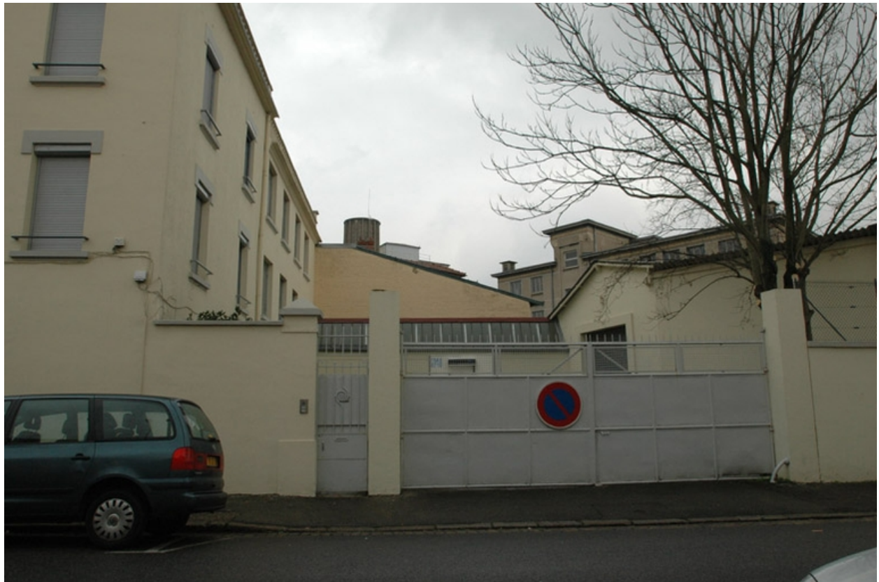
Entrée principale rue Roux Soignat, vue ouest.
