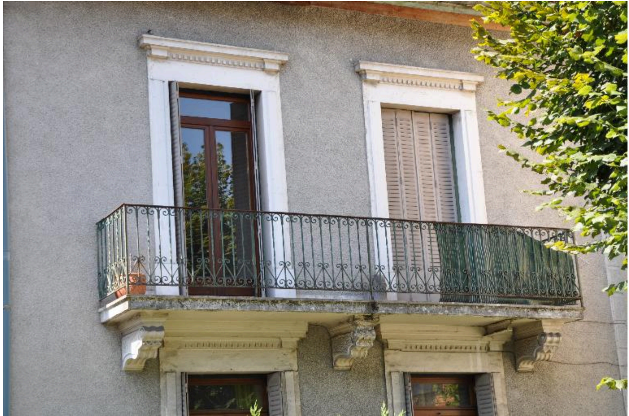
Détail sur le balcon et les encadrements des baies de l'élévation orientale
