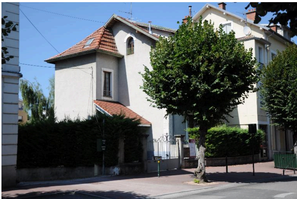
Façade sud, vue de trois-quart depuis le sud-est
