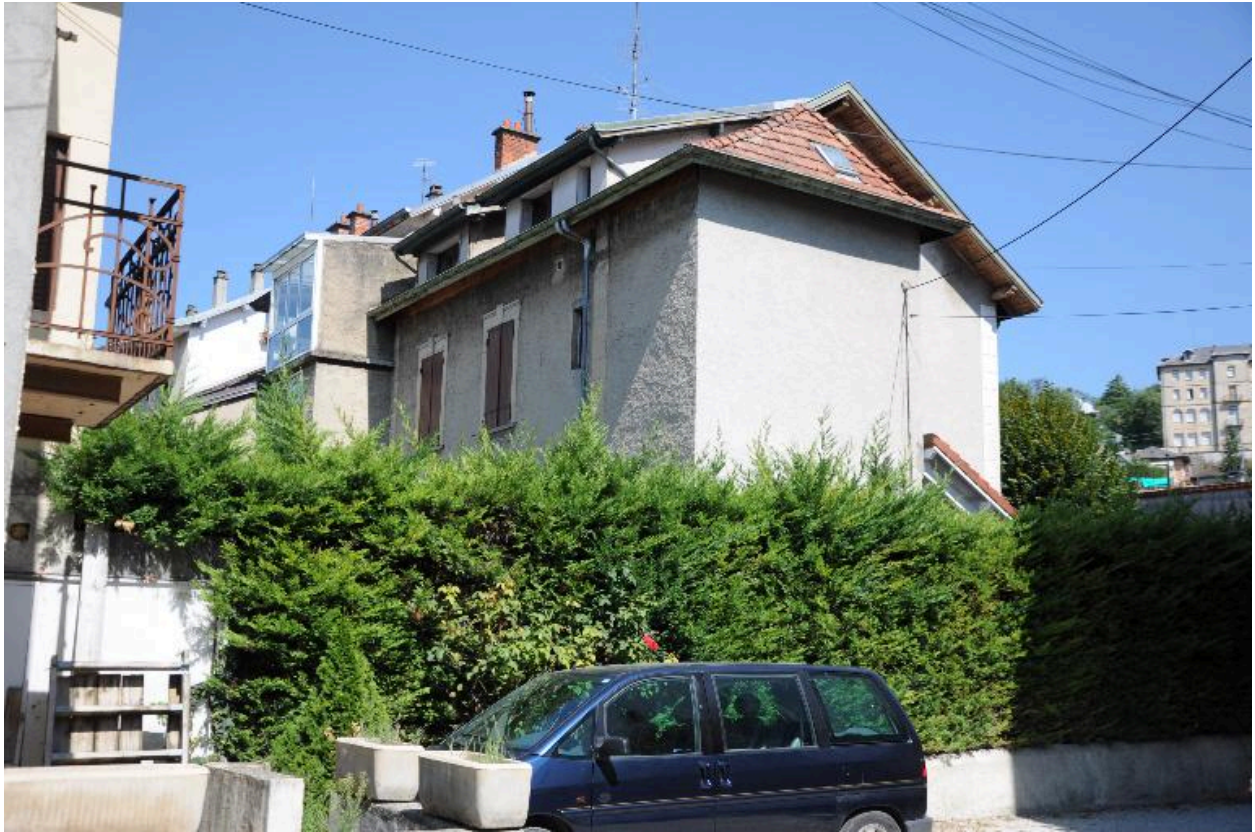
Façade postérieure, vue de trois-quart depuis le sud-ouest
