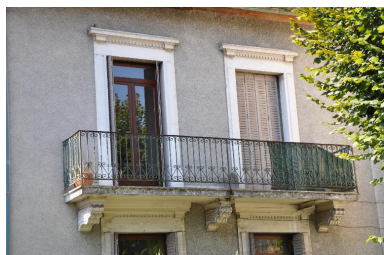
Détail sur le balcon et les encadrements des baies de l'élévation orientale Phot. Denys Harreau IVR82_20137300868NUCA
