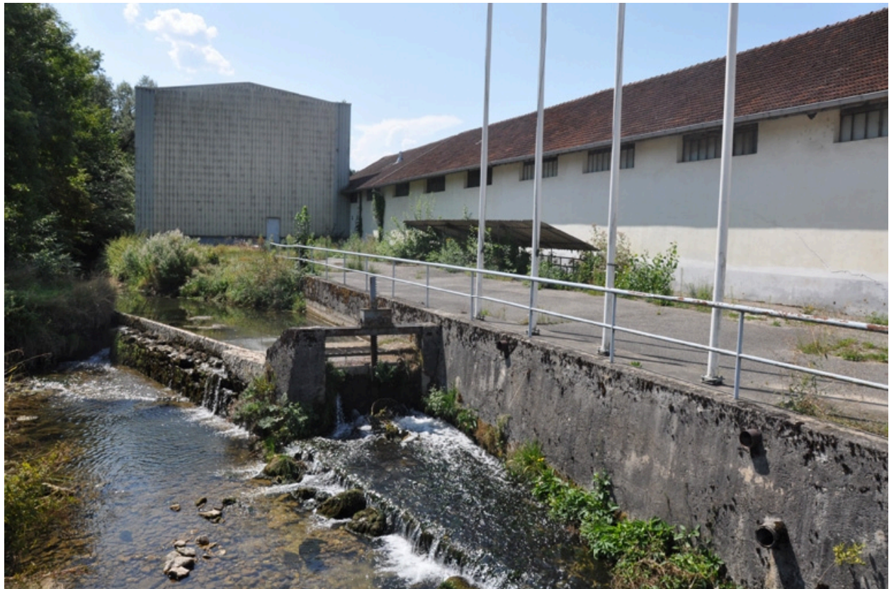
Détail de l'ancienne prise d'eau avec le vannage
