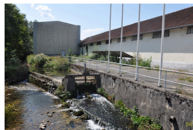
Détail de l'ancienne prise d'eau avec le vannage Phot. Yannick Milleret IVR82_20107300356NUCA
