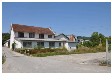
Vue générale des bâtiments administratifs Phot. Yannick Milleret IVR82_20107300354NUCA
