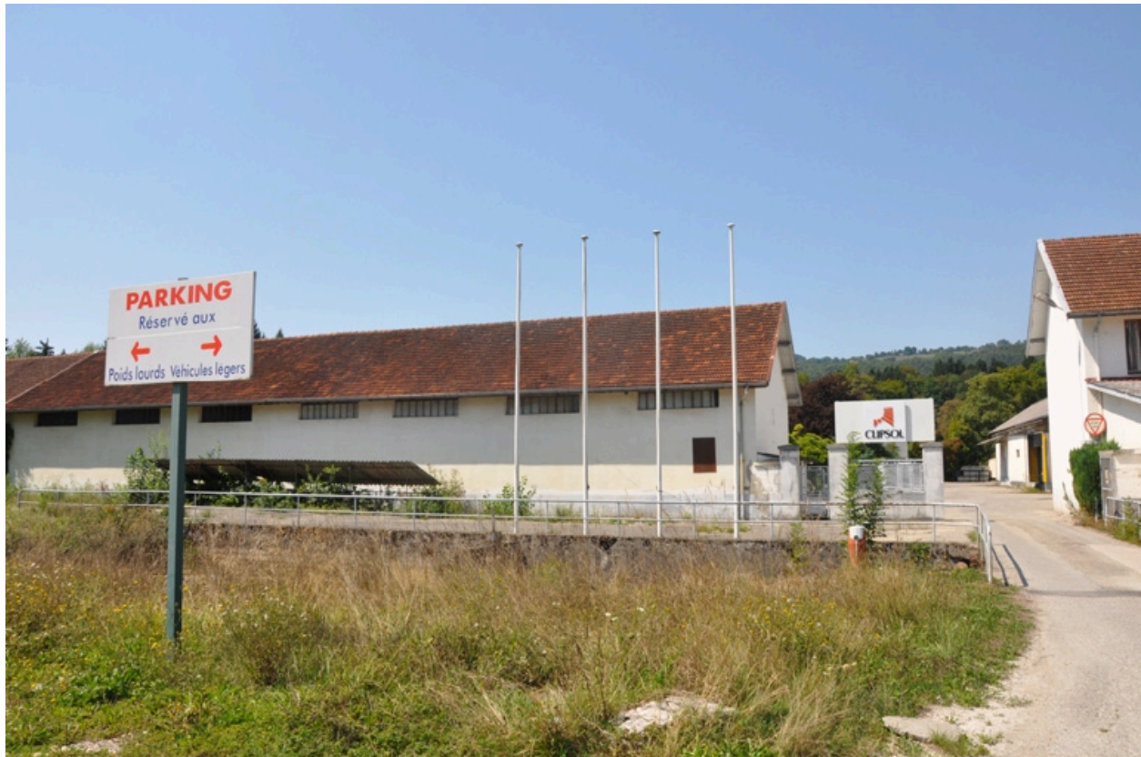
Vue de la façade est du bâtiment de stockage
