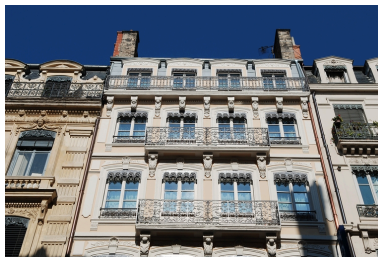
Elévation antérieure : partie supérieure Phot. Véronique Belle IVR82_20096904731NUCA
