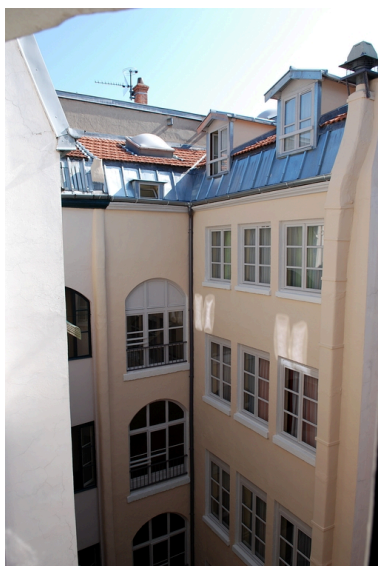
Elévation sur cour depuis l'escalier ouest du 9 rue des Archers Phot. Véronique Belle IVR82_20096904734NUCA
