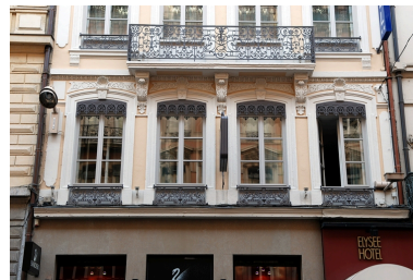
Elévation antérieure : premier et deuxième étages carrés Phot. Véronique Belle IVR82_20096904732NUCA
