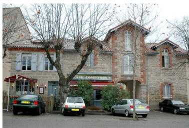
Vue générale de la maison, partie gauche.
