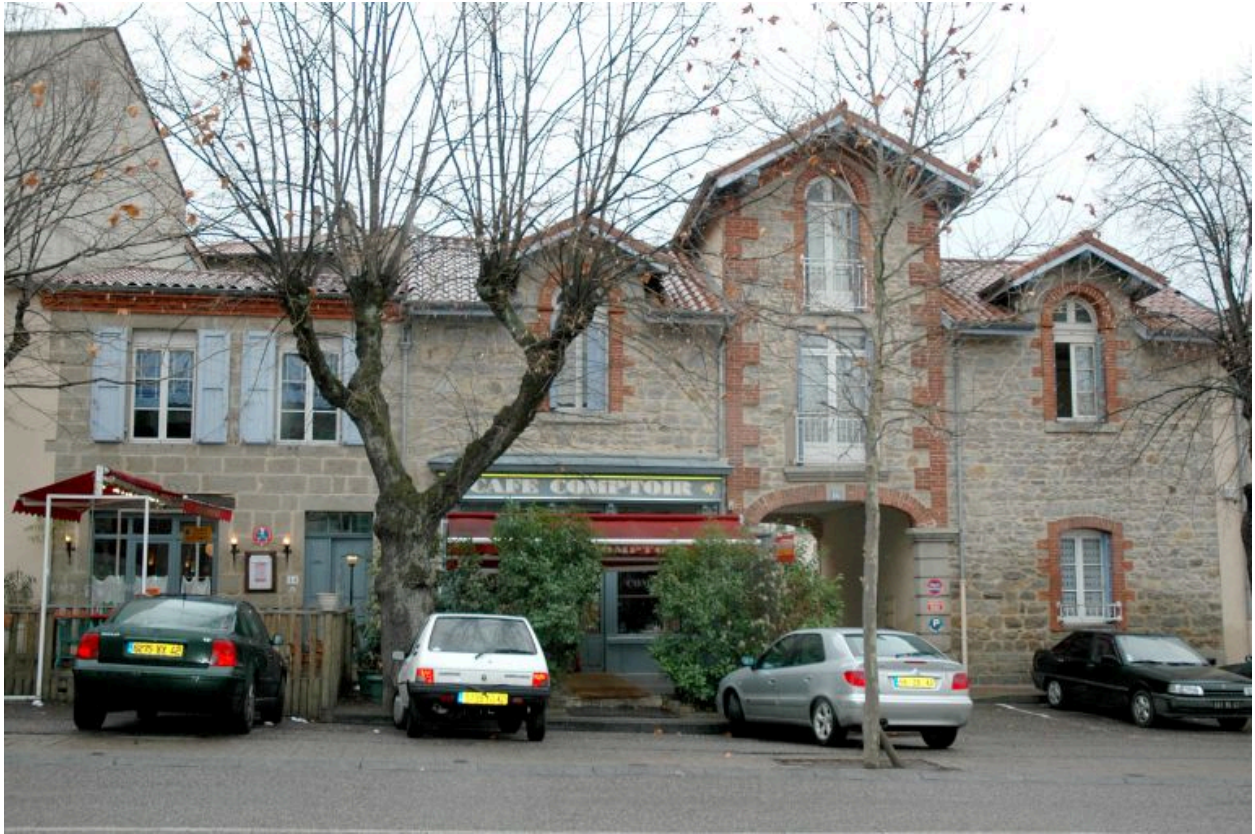
Vue générale de la maison, partie gauche.
