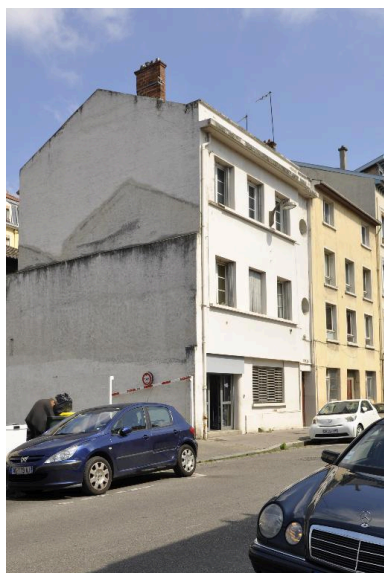
Vue d'ensemble, depuis le sud-est Phot. Catherine Guégan IVR84_20166900698NUCA
