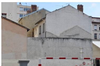
Mur pignon sud, traces possibles des anciens bâtiments remaniés et agrandis en 1935 Phot. Catherine Guégan IVR84_20166900699NUCA
