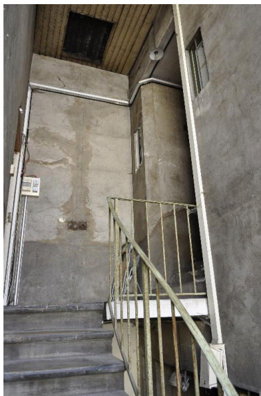
Vue du dernier palier de l'escalier Phot. Catherine Guégan IVR84_20166900701NUCA
