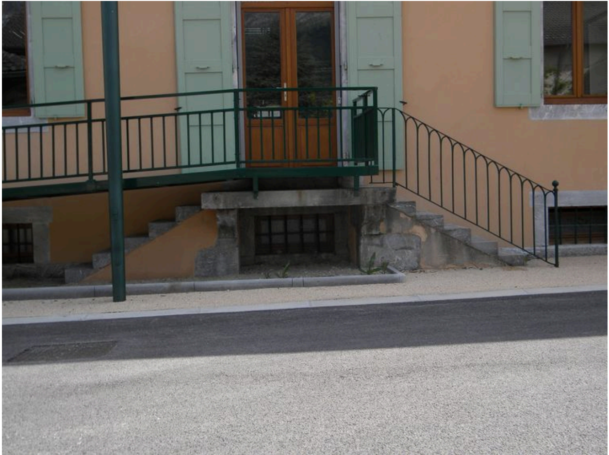
Détail de l'ancien perron sous la rampe d'accès pour handicapés sur la façade arrière.
