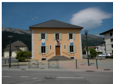
Vue générale de la façade principale.
