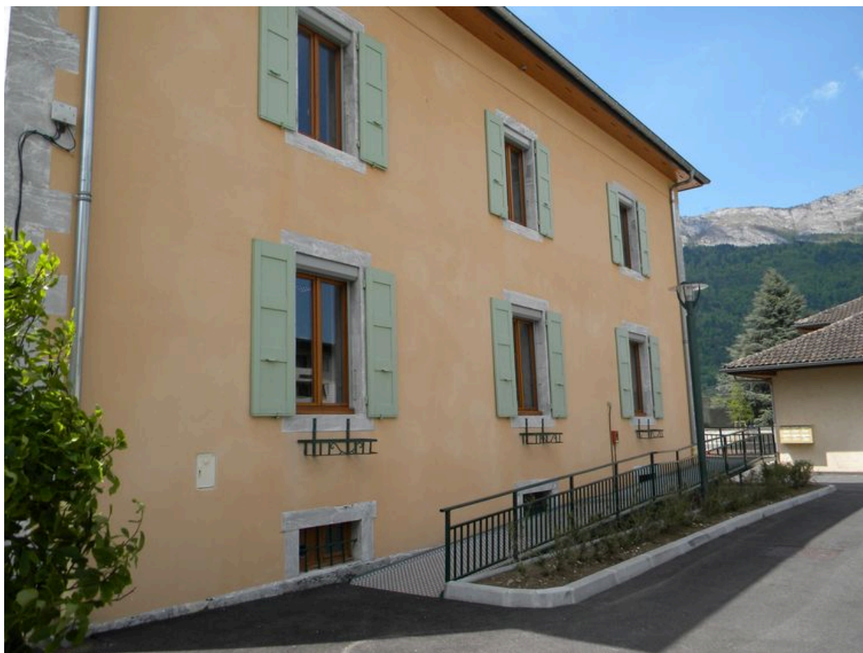
Vue de la façade nord.
