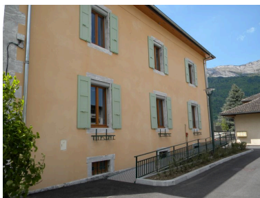
Vue de la façade nord.
