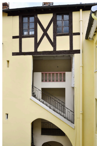
Escalier : étages supérieurs Phot. Thierry Leroy IVR84_20266900247NUCAQ
