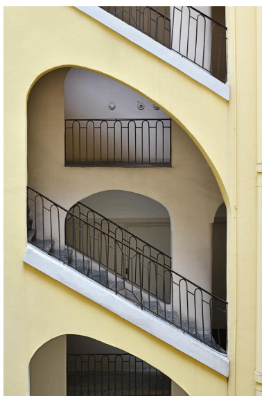
Escalier : détail Phot. Thierry Leroy IVR84_20266900234NUCAQ
