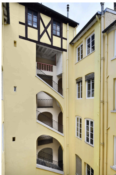
Elévation postérieure et cage d'escalier Phot. Thierry Leroy IVR84_20266900246NUCAQ
