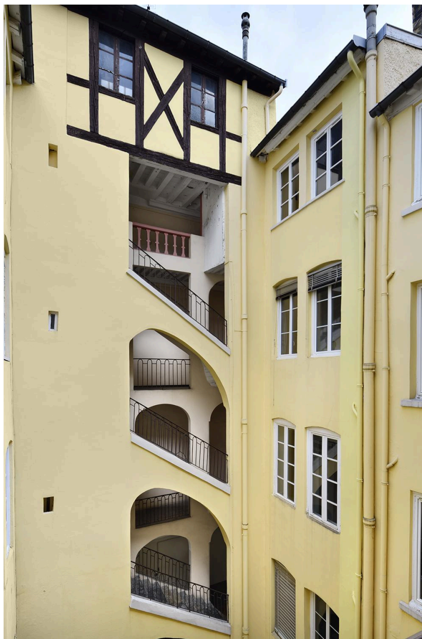
Elévation postérieure et cage d'escalier
