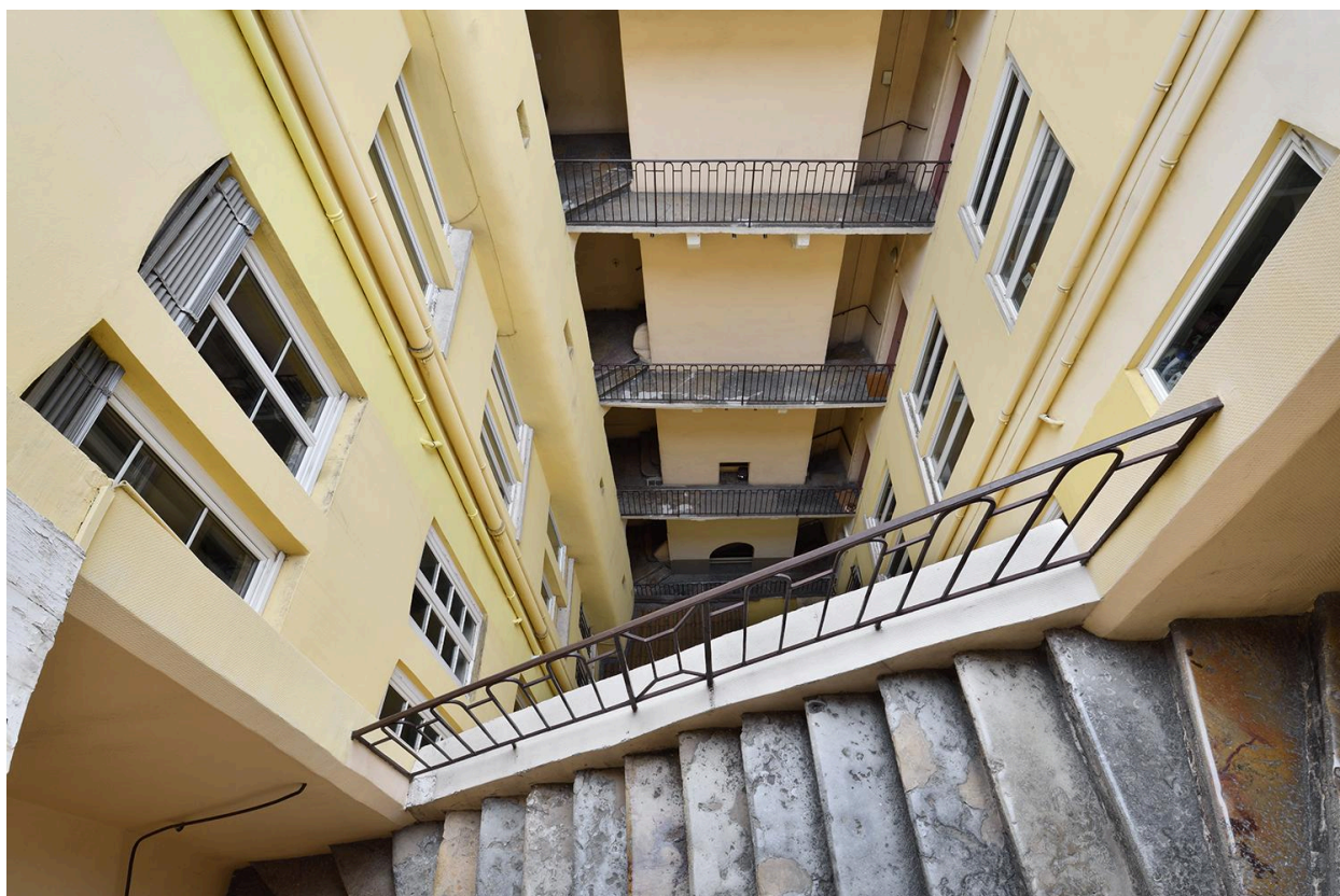
Au premier plan, volée d'escalier et élévation postérieure. A l'arrière-plan, escalier de l'immeuble sis 3 rue Jean-de-Tournes
