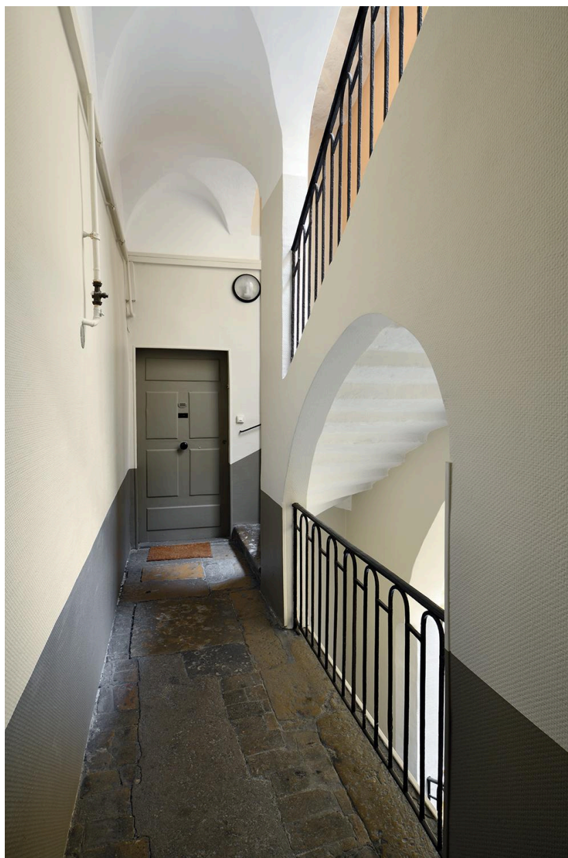
Escalier : palier voûté d'arêtes
