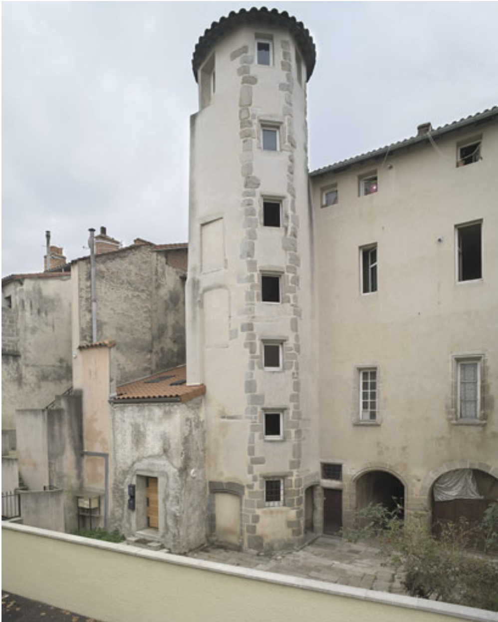
Vue générale sur cour.
