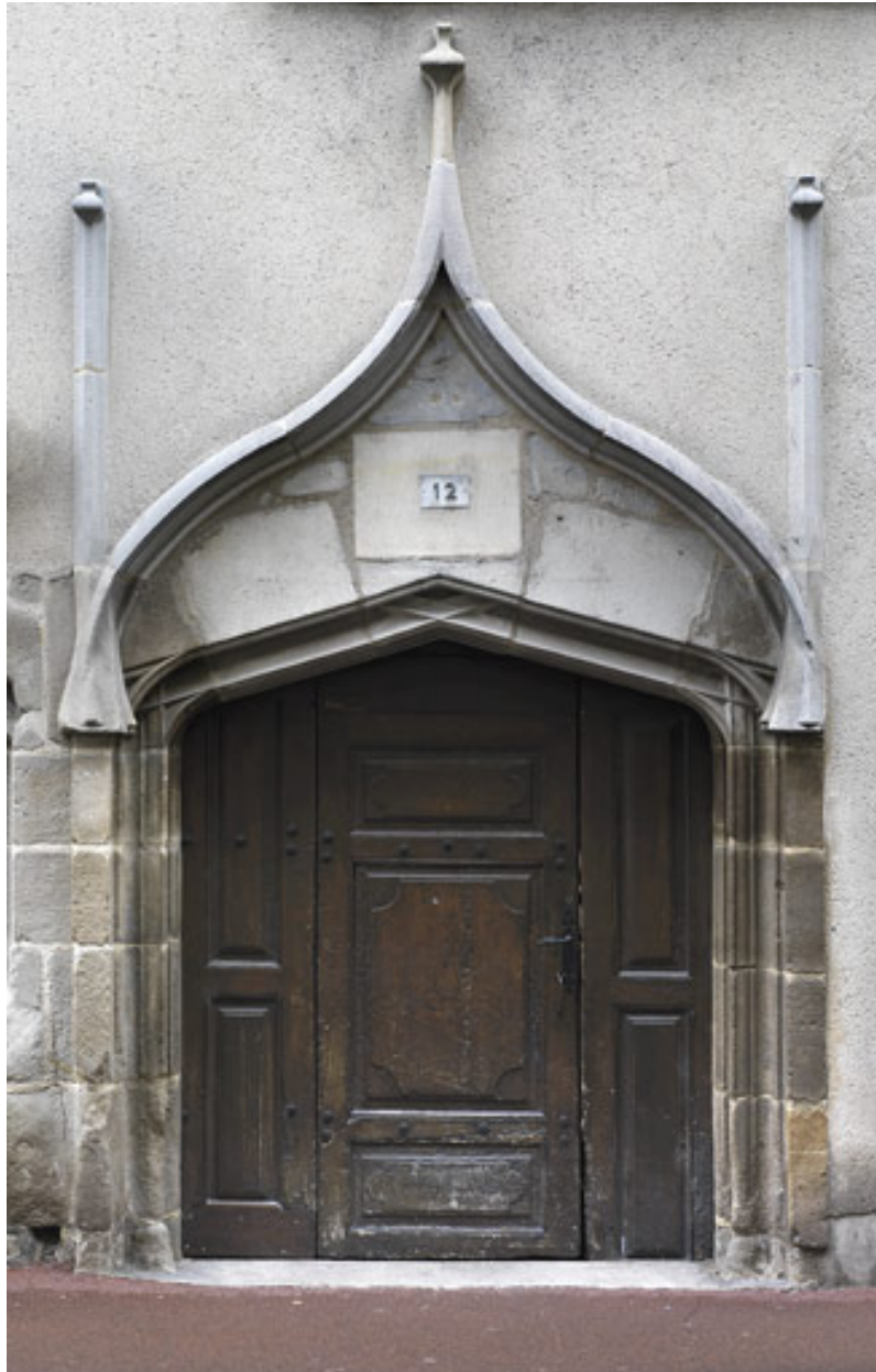
Porte piétonne à gâble et pinacles.
