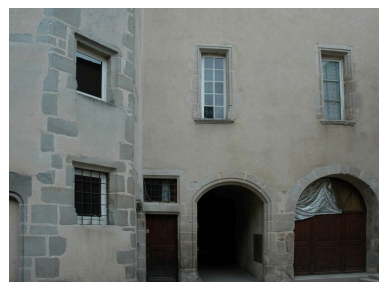
Vue du rez-de-chaussée sur cour. Phot. Simone Hartmann-Nussbaum IVR82_20124202778NUCA
