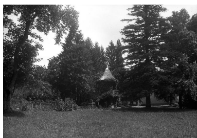
La tour de jardin, vue prise du sud-ouest, vers 1930 Phot. Denys Harreau IVR82_20147300005NUCB
