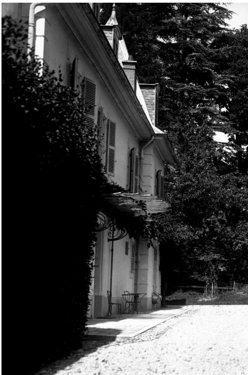
Vue sur la marquise de la façade sud, vers 1930
