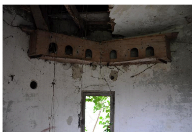
La tour ronde, ou pigeonnier, nichoir en bois à l'intérieur de la tour Phot. Denys Harreau IVR84_20167300006NUCA
