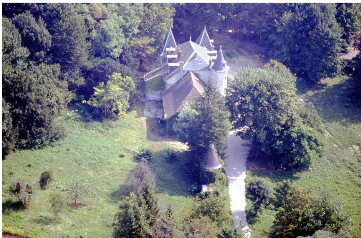
Vue aérienne, vue générale depuis l'ouest, 1993
