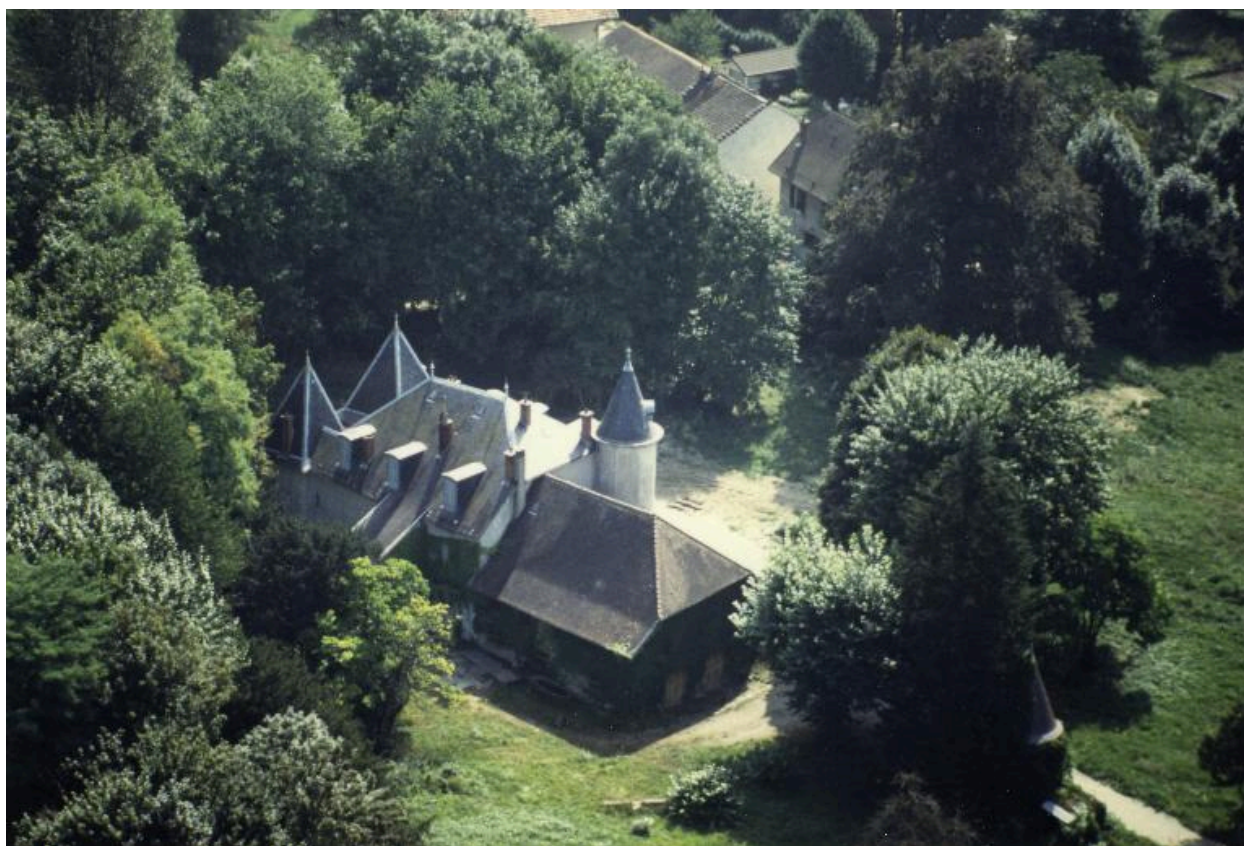
Vue aérienne, façade nord, 1993
