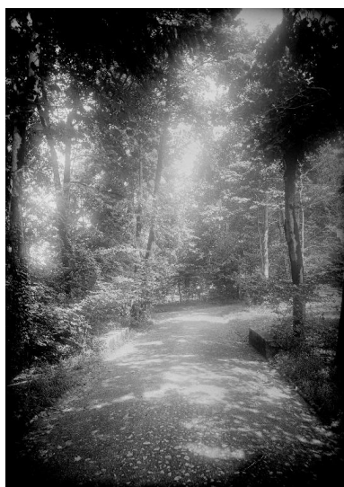
Le ponceau de l'entrée secondaire, vers 1930 Repro. Denys Harreau IVR82_20147300007NUCB
