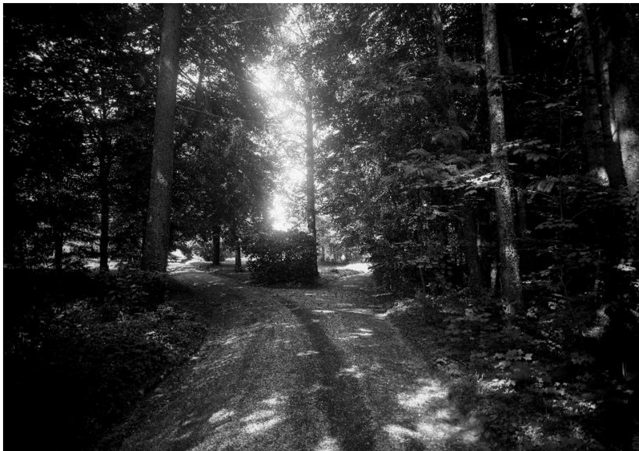
Allée boisée de l'entrée principale, vers 1930
