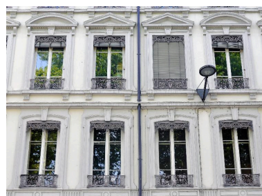
Vue rapprochée : décor des baies du premier et deuxième étages Phot. Magali Delavenne IVR82_20146902700NUCA
