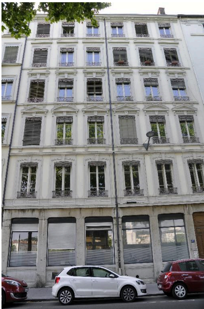
Vue générale de l'élévation sur quai
