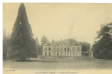
Château de la Charnée vu du nord-est. Carte postale ancienne. Repro. auteur inconnu, Phot. Petit IVR84_20240300182NUCA
