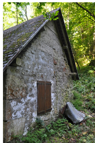
Vue façade nord Phot. Yannick Milleret IVR82_20107300328NUCA
