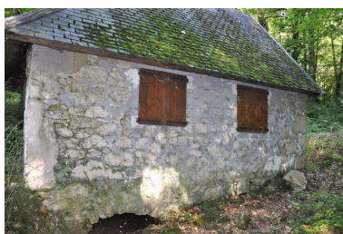
Vue façade est Phot. Yannick Milleret IVR82_20107300327NUCA
